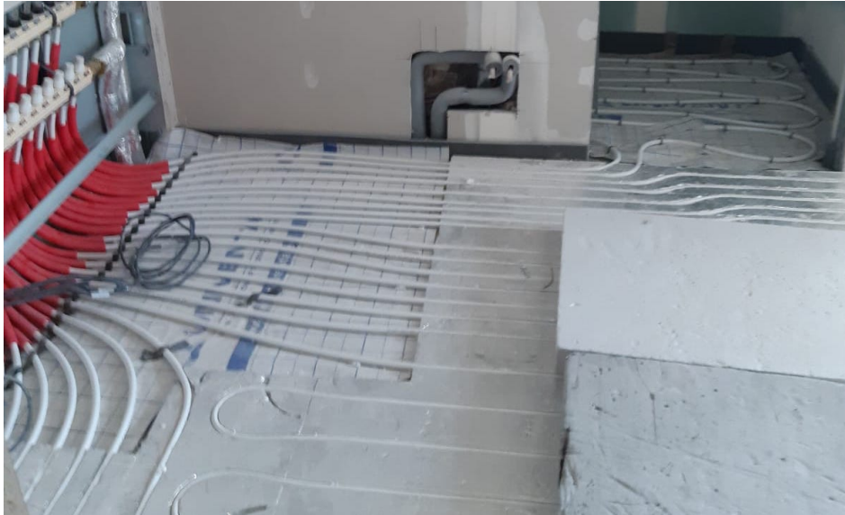
Obrázek č.7: Realizace podlahového vytápění
