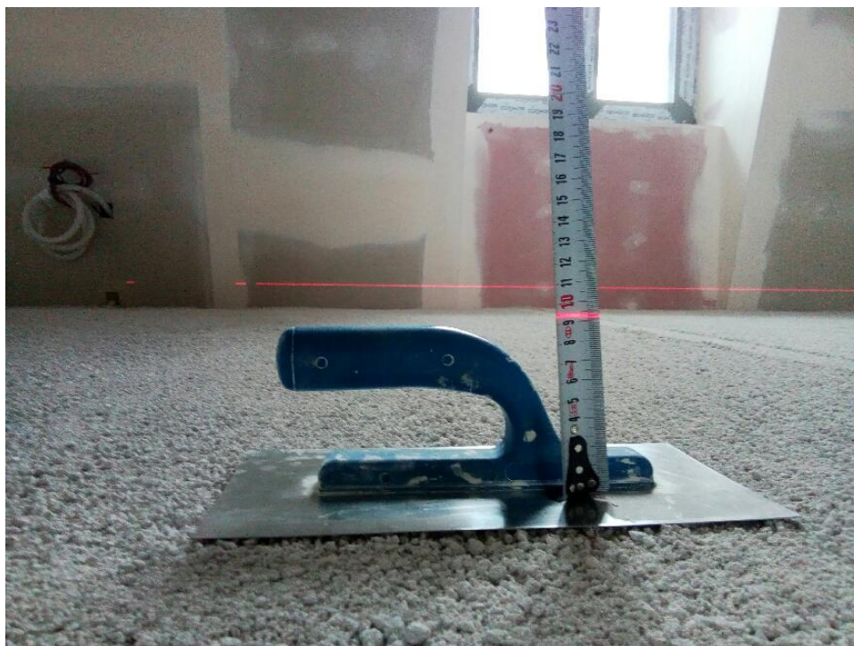
Obrázek č.6: Pohled na vrstvu vyrovnávacího podsypu
