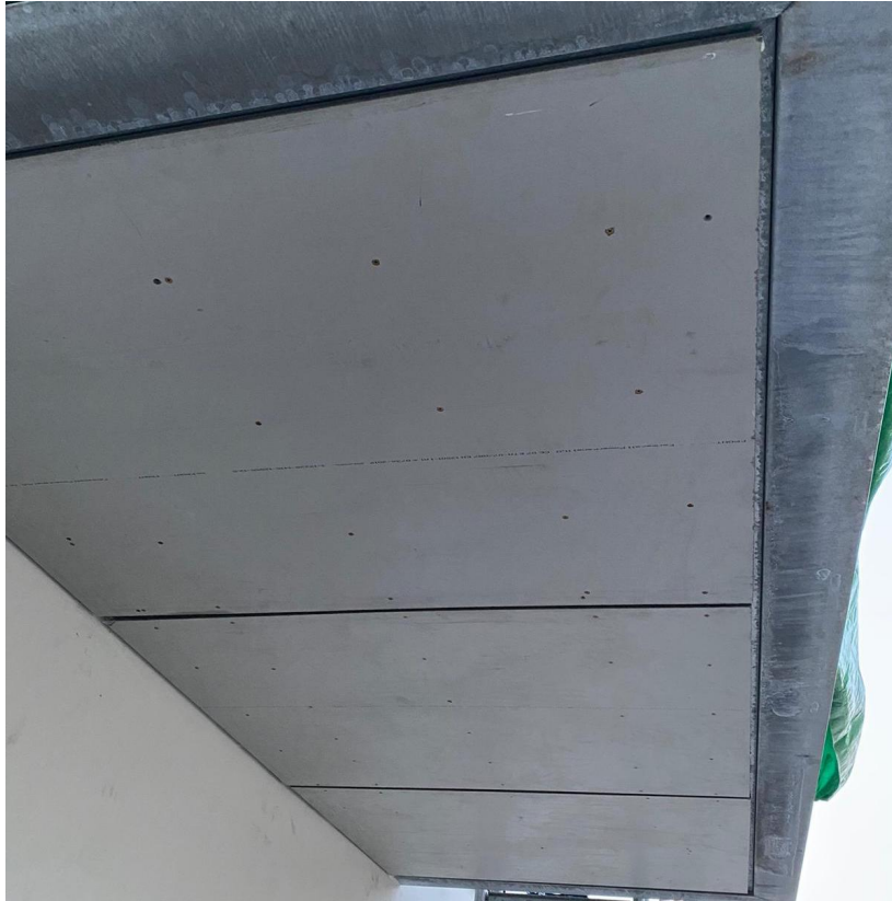
Obrázek č.3: Venkovní konstrukce opláštěna cementovláknitými deskami
