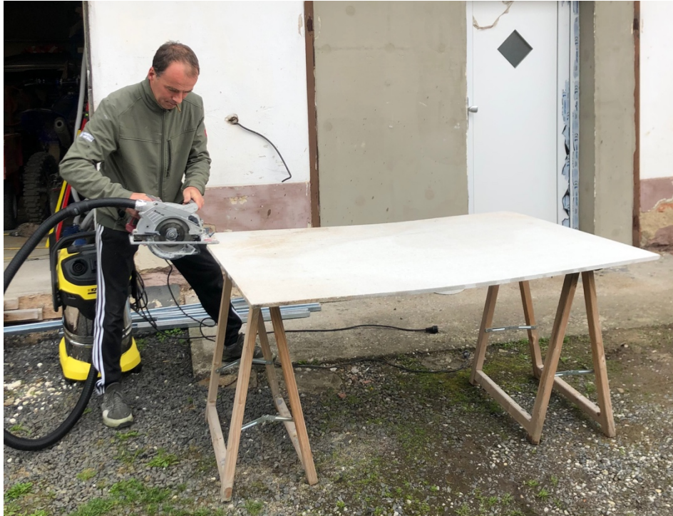
Obrázek č.5: Řezání pilou napojenou na vysavač
