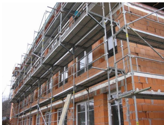
Obr. 7 Fasádní lešení [38]
