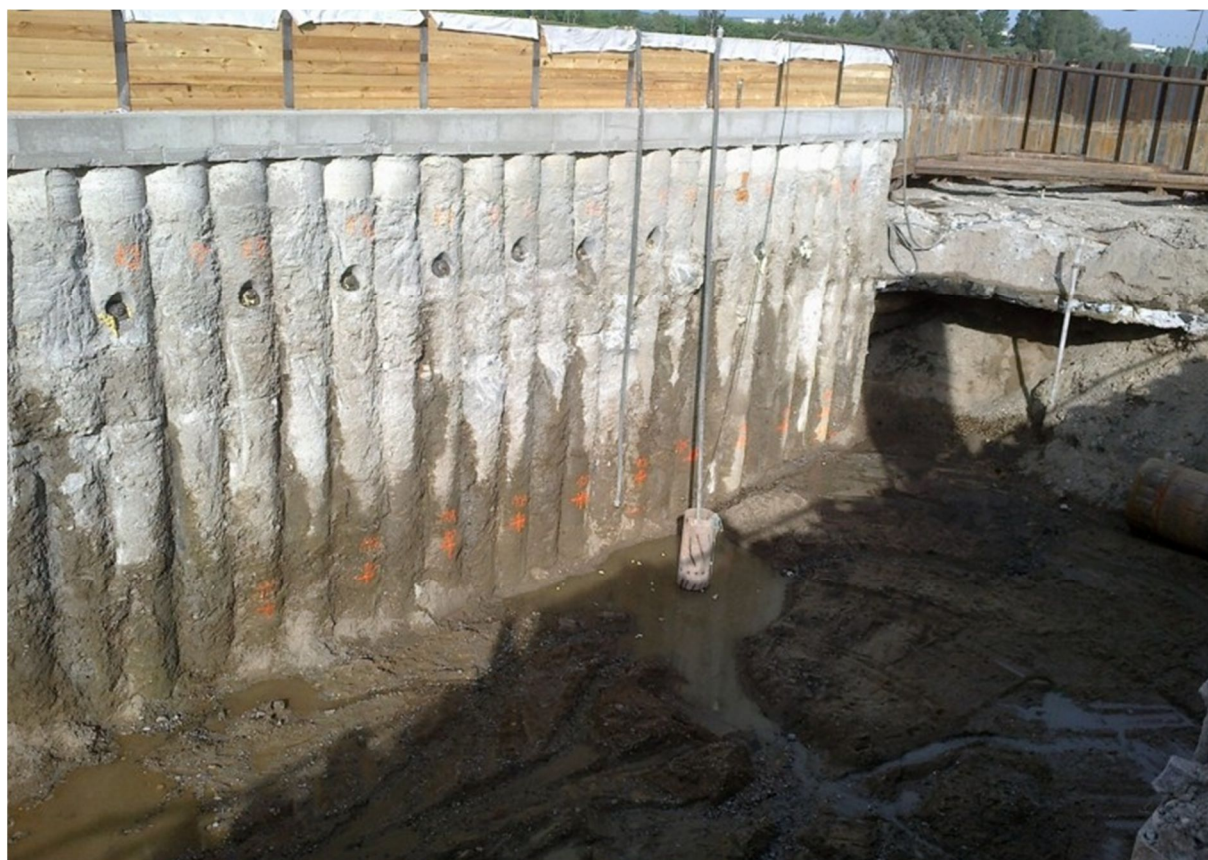
Obr. č. 10 - Převrtávaná pilotová stěna (zdroj: [7])
