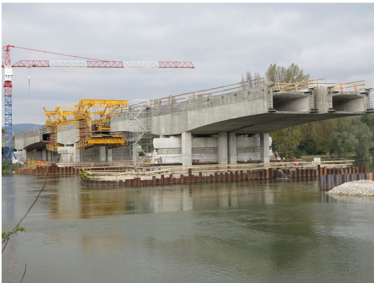
Obr. č. 12 - Štětovnicová stěna – zakládání mostu přes řeku Váh (zdroj: [19])
