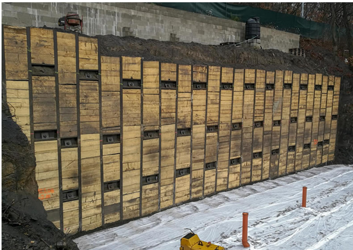
Obr. č. 8 - Záporové pažení (zdroj: [17])
