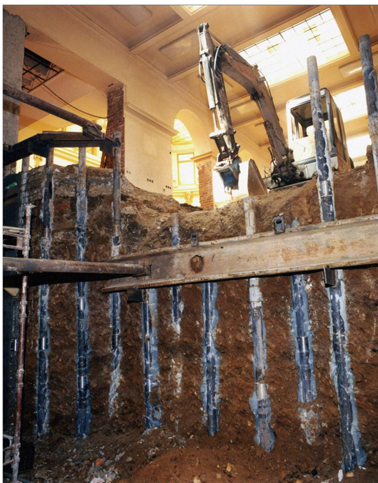
Obr. č. 7 - Mikrozáporové pažení (zdroj: [4])
