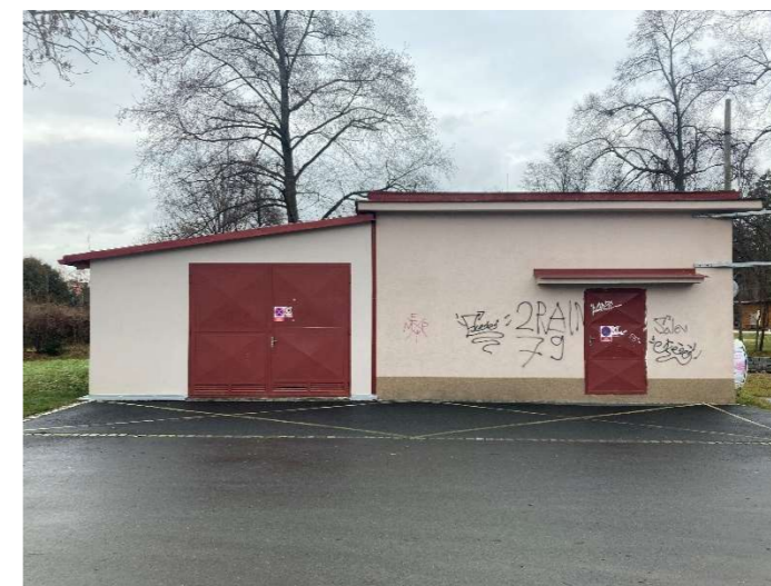
Obr. 97 - Budova technické infrastruktury
