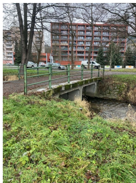
Obr. 90 - Vjezd do území přes železobetonový mostek
