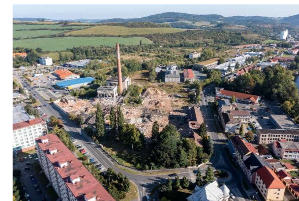
Obr. 54 - Výšková fotografie probíhající demolice továrních budov (autor: Ing. Čestmír Kříž)
