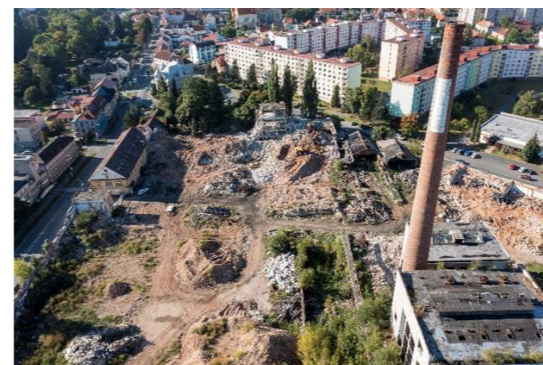
Obr. 53 - Výšková fotografie probíhající demolice továrních budov (autor: Ing. Čestmír Kříž)
