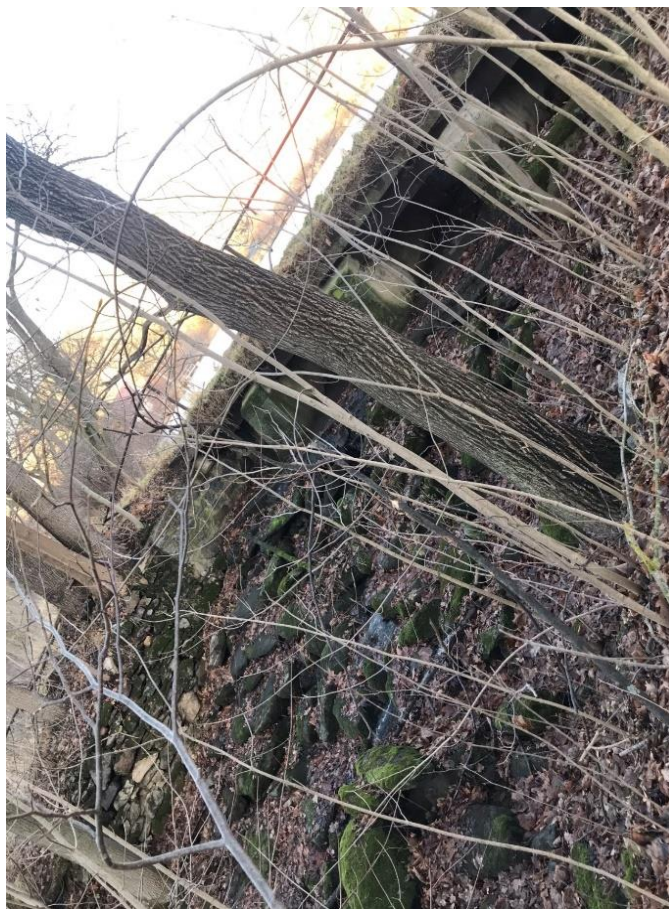
Foto 15 – Kamenný skluz bezpečnostního přelivu – rybník Mitrovice
