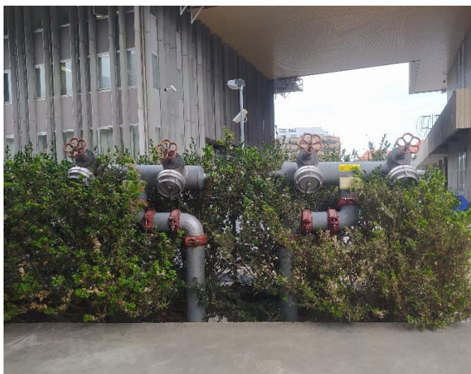
obr. 6 Připojení mobilní techniky (vlastní foto)
