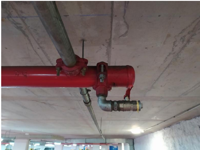
obr. 18 Vypouštěcí armatura (vlastní foto)
