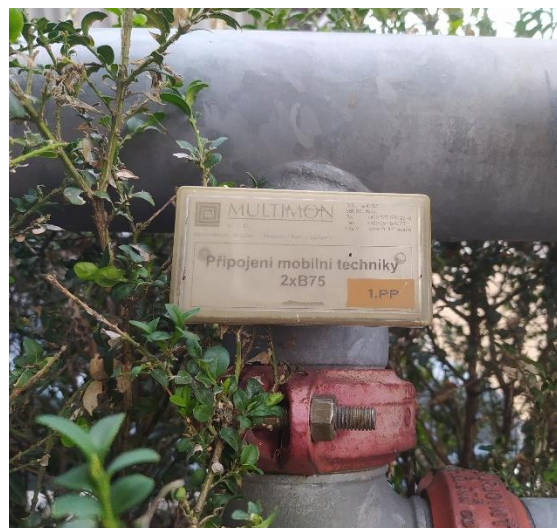
obr. 7 Označení připojení mobilní techniky (vlastní foto)
