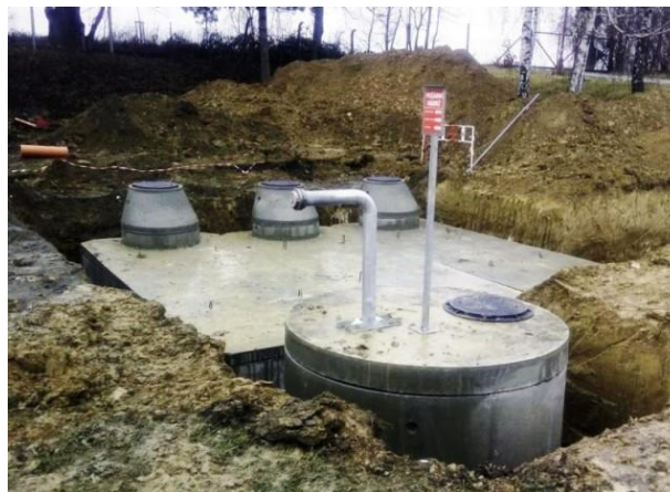
obr. 9 Podzemní požární nádrž [9]
