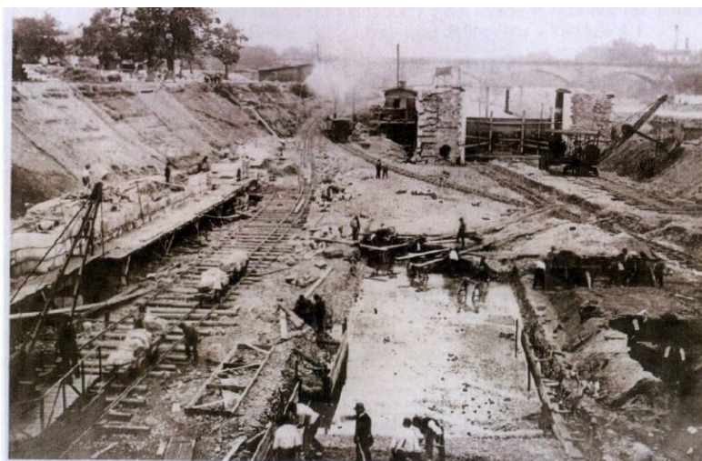
Obr.22 : Výstavba plavební komory [19]
