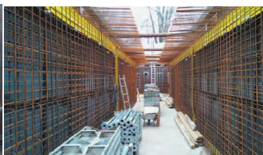
Obr. 12: Odbočná větev – armování definitivního ostění [13]
