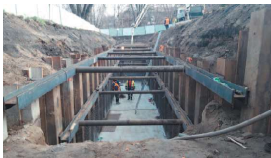
Obr. 11: Odbočná větev – provádění výkopů [13]
