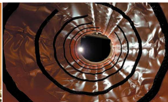
Obr. 14: Šachta J104 s instalovanými spárovými pásy a mezilehlou izolací [13]
