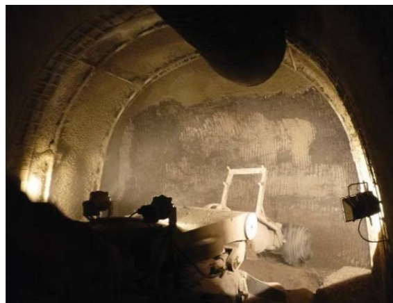
Obr. 7: Ražba pomocí razicího stroje s frézou na výložníku [15]
