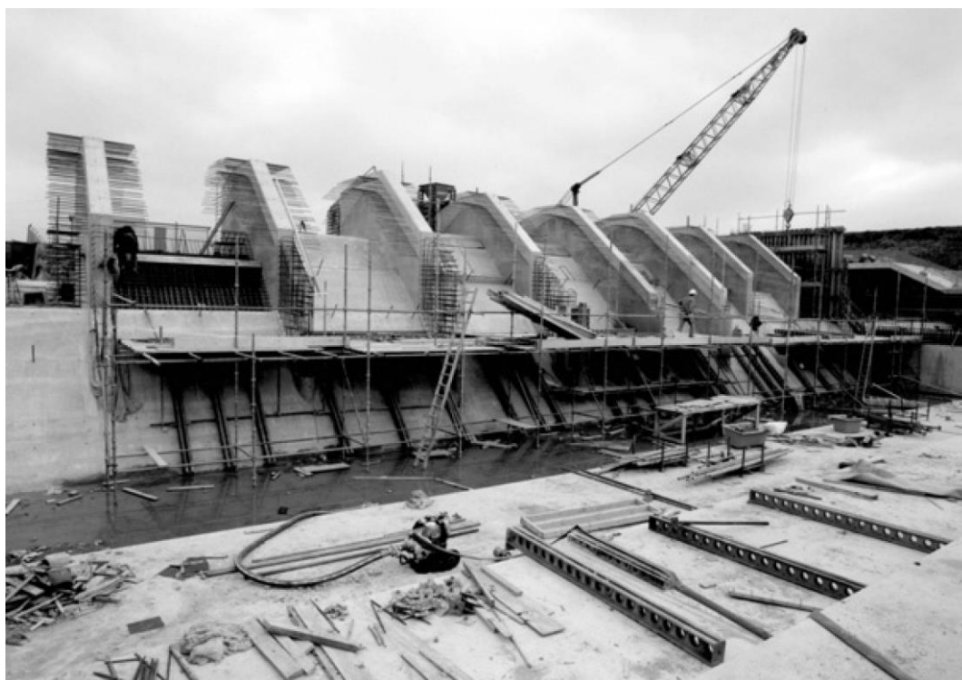
Obrázek 6 TONKS, D. M.; HOWELLS, R.; BETTESS, R. a kol., výstavba nového jezu 1993-94 [fotografie]
