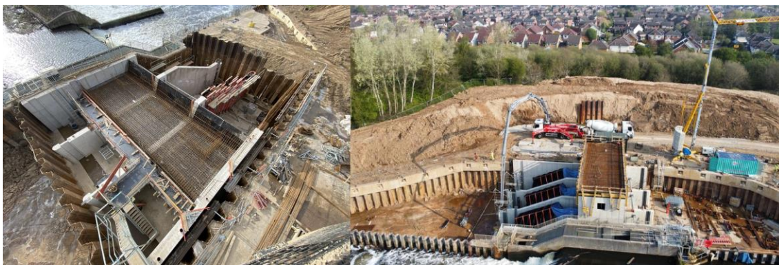
Obrázek 10 HANUS, D., průběh výstavby, vlevo - armování strojovny, vpravo - pohled na stavbu [fotografie]
