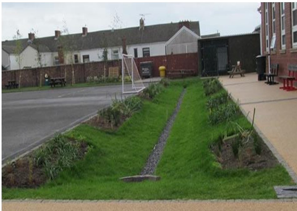
Obr.11. - Realizovaný 30 m dlouhý terénní průleh [26]
