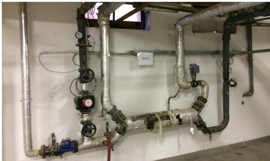
Obr. 18. – Příprava TV (protiproudý výměník)
