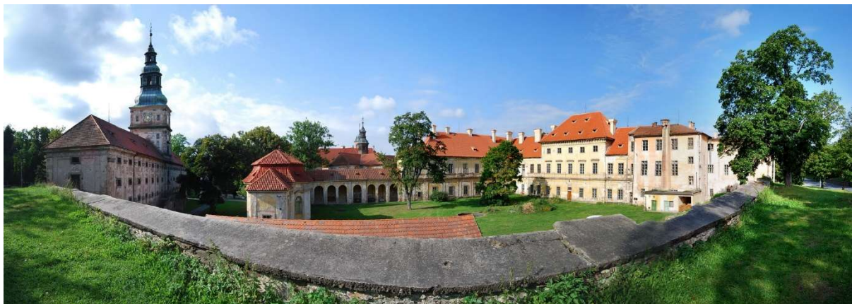
Obrázek 3 Dvůr před rekonstrukcí (2)
