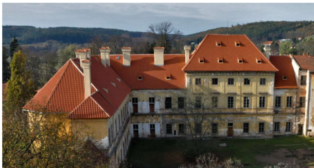
Obrázek 2 Prelatura před rekonstrukcí (2)
