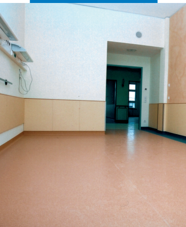
Ukázka instalace PVC v pásech – Nemocnice San Joseph – Německo
