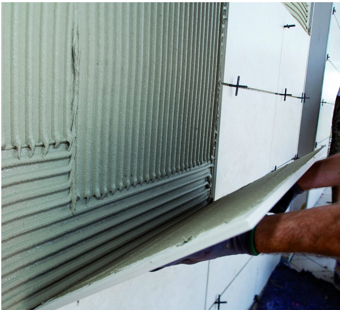
Obrázek 14 - Lepení obkladů na stěnu [22]
