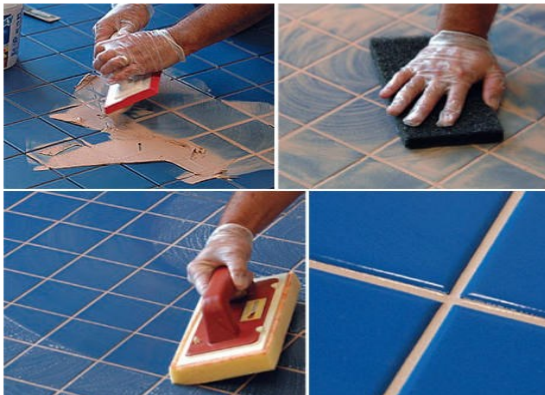
Obrázek 18 - Spárování dlažby / obkladů [26]
