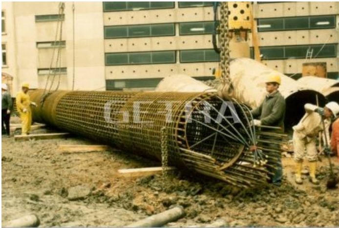
Obrázek 7 Energopiloty – uložení potrubí – jednotlivé smyčky [7]
