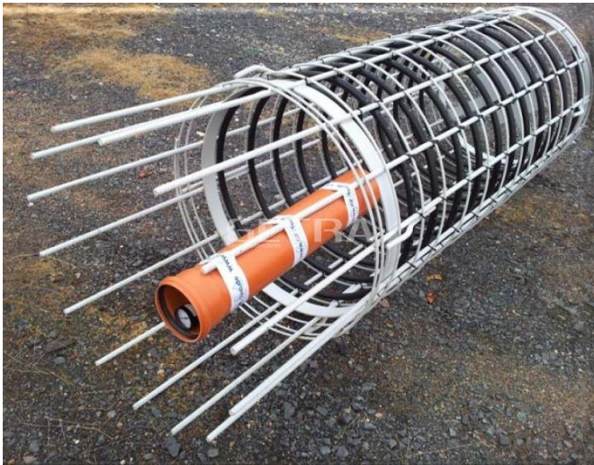
Obrázek 5 Energopiloty – uložení potrubí – spirála [7]
