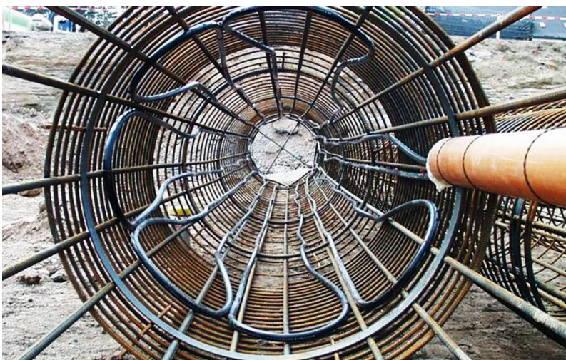
Obrázek 6 Energopiloty – uložení potrubí – meandr [3]
