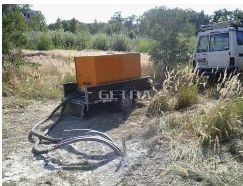
Obrázek 5 – GE.TRA - provádění TRT testu[9]
