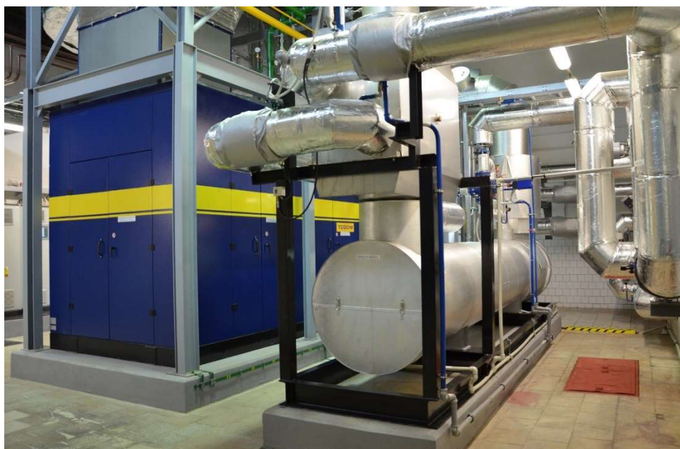
Obr. 22: Kogenerační jednotka [4]
