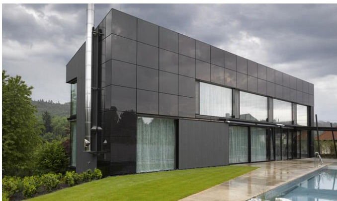
Obrázek 17 - Fotovoltaická fasáda
