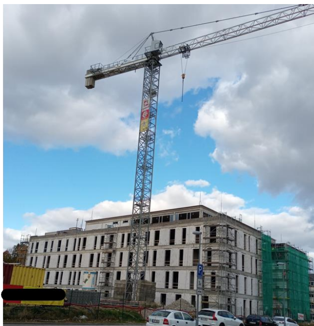
Obr. 2 - staveništní jeřáb [vlastní zdroj]
