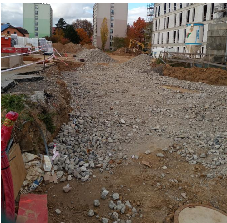
Obr. 5 – vnitro staveništní komunikace [vlastní zdroj]
