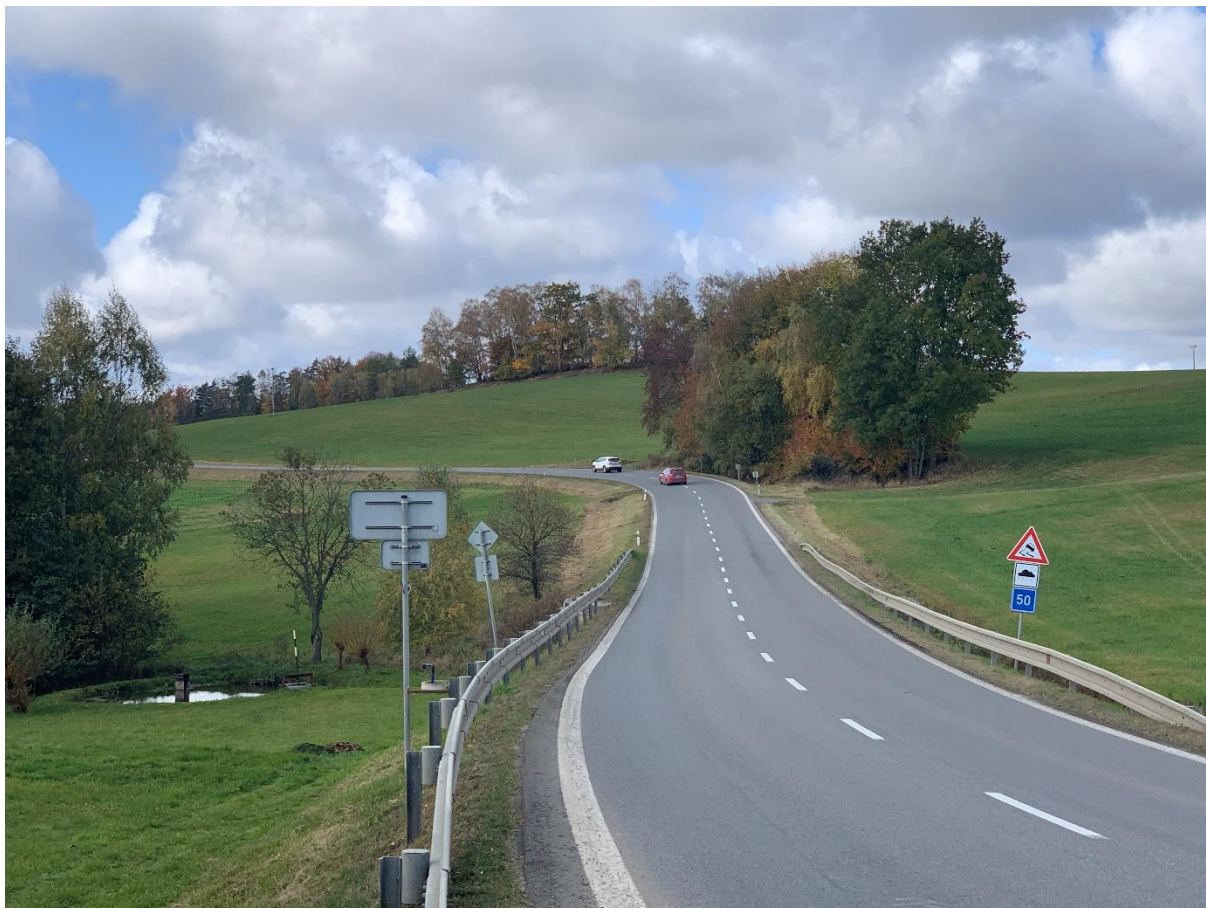
Obr. 4: Malé poloměry směrových oblouků na silnici I/34
