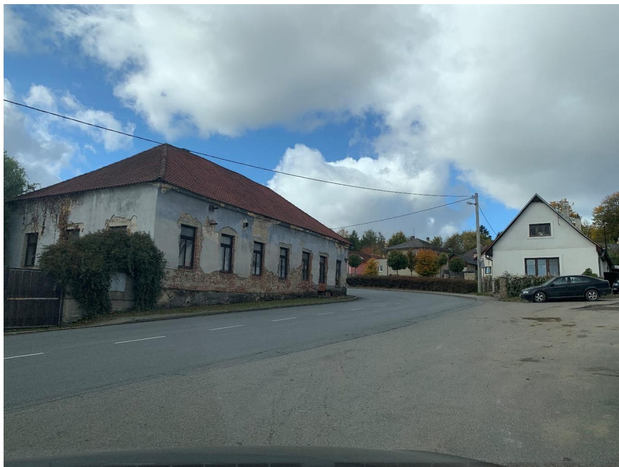
Obr. 3: Nebezpečné místo v obci Věž
