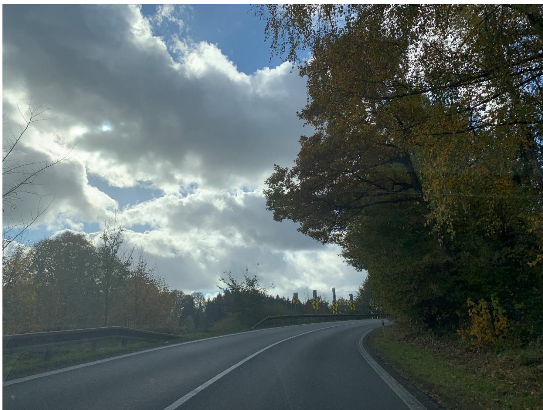
Obr. 5: Malé poloměry směrových oblouků na silnici I/34
