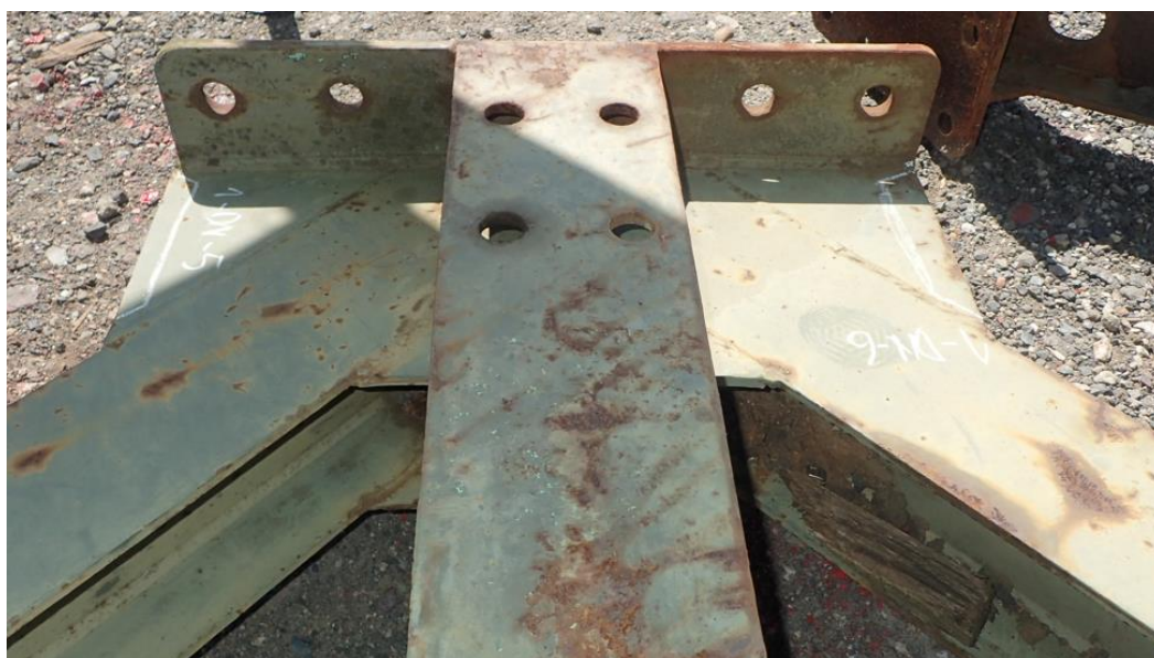
Obrázek 89 Stýčnik - horní pás [9]
