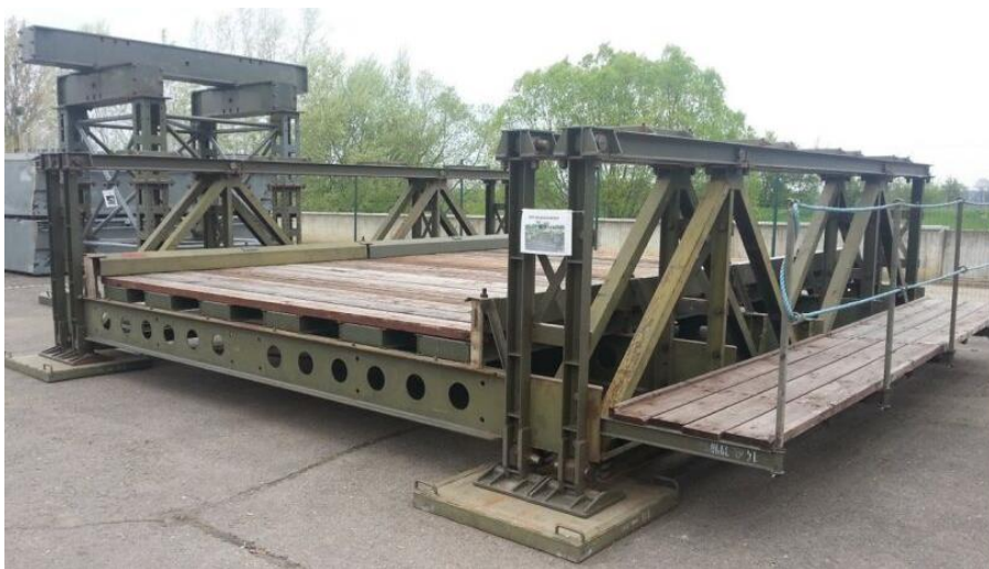
Obrázek 3 TMS - těžká mostová souprava [5]
