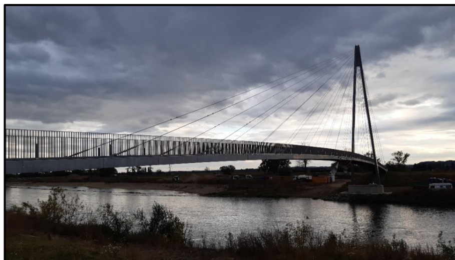
Obr. 18 Pohled na lávku v Lužci nad Vltavou
