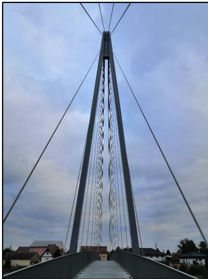
Obr. 19 Pohled na pylon směrem od Bukolu na Lužec nad Vltavou
