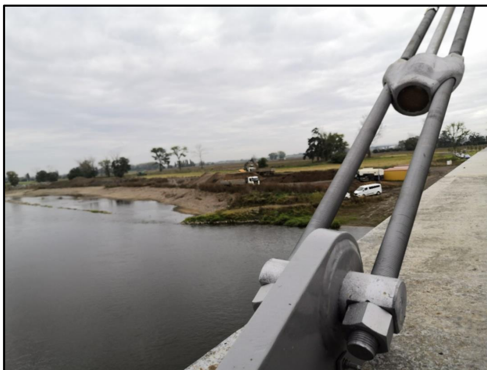
Obr. 26 Kloubové připojení závěsu k mostovce
