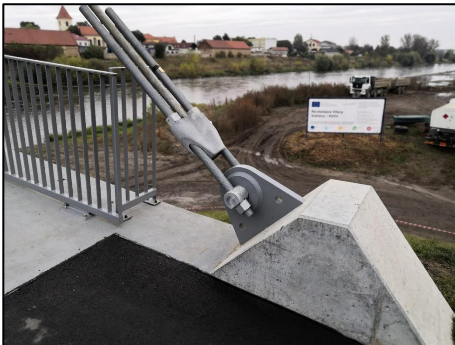
Obr. 17 Pohled na kotevní blok pro uchycení reverzního závěsu u opěry O3
