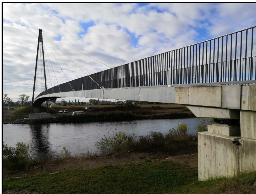
Obr. 14 Lávka v Lužci nad Vltavou – pohled ve směru staničení lávky
