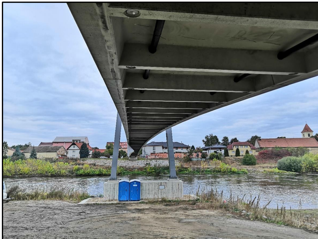
Obr. 16 Pohled na vodorovnou nosnou konstrukci zespoda od opěry O3 směrem na Lužec nad Vltavou
