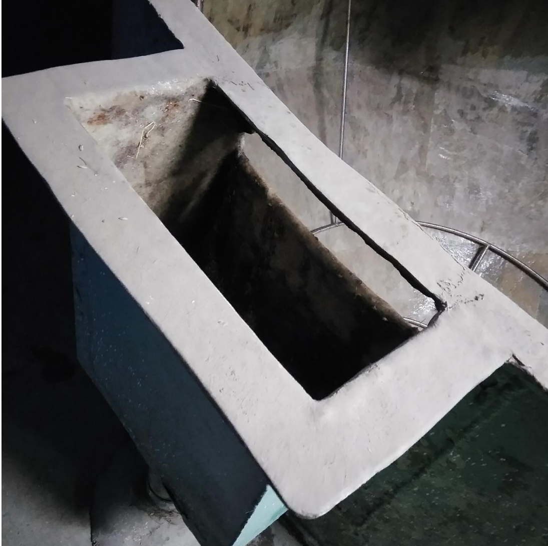
Obrázek 27 – Pevná přelivná hrana náduvníku. Zdroj: vlastní foto
