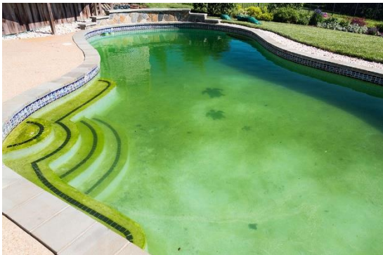
Obr. č. 42 – Zelené řasy po celé ploše bazénu; lakeshorepoolsandtubes.com
