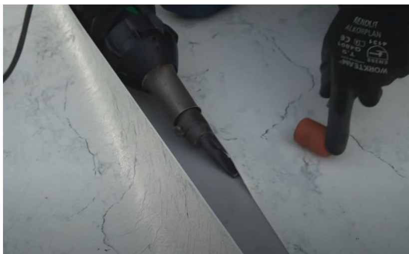
Obr. č. 26 – Svařování fólií u dna s využitím podkladního svařovacího pásu (18)
