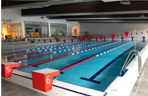
Obr. č. 3 – Ukázka plaveckého bazénu v Prachaticích; stavba.tzb-info.cz
