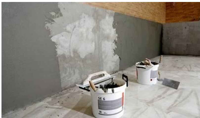
Obr. č. 10 – Aplikace bazénové stěrky; iDNES magazíny, hobby
