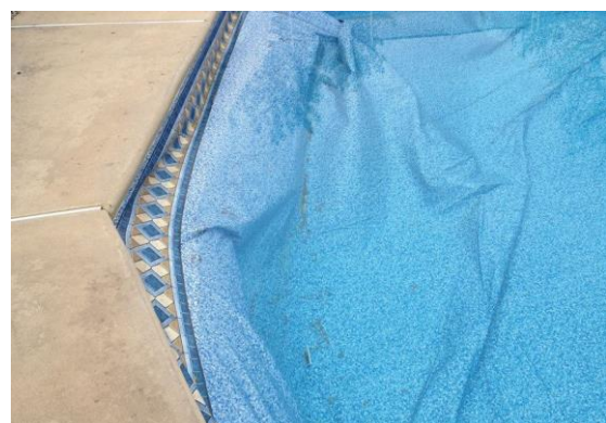
Obr. č. 16 a 17 – Poškození: protržení fólie (vlevo), rolování špatně napnuté fólie (vpravo); uvpools.com, damaged pool liner; poolspanews.com
