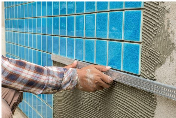
Obr. č. 13 – Instalace bazénového obkladu na lepidlo; aquanomicspools.com
