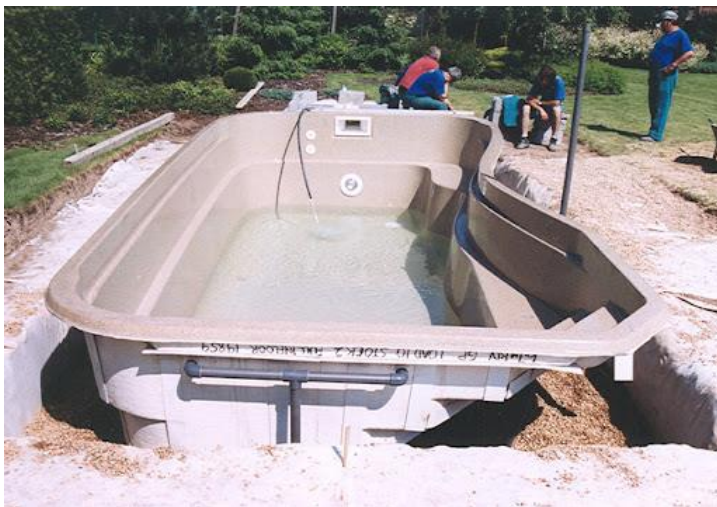
Obr. č. 8 – Zapouštění bazénové vany z laminátu do země; bazeny-dvorak.cz, Dvořák s.r.o.
