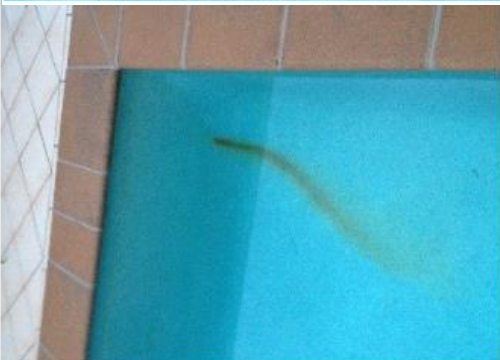
Obr. č. 41 – Skvrny od rzi způsobené kovovou šponou po broušení
