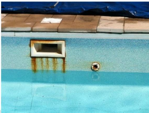
Obr. č. 40 – Skvrny od rzi způsobené korozi kovových armatur bazénu
