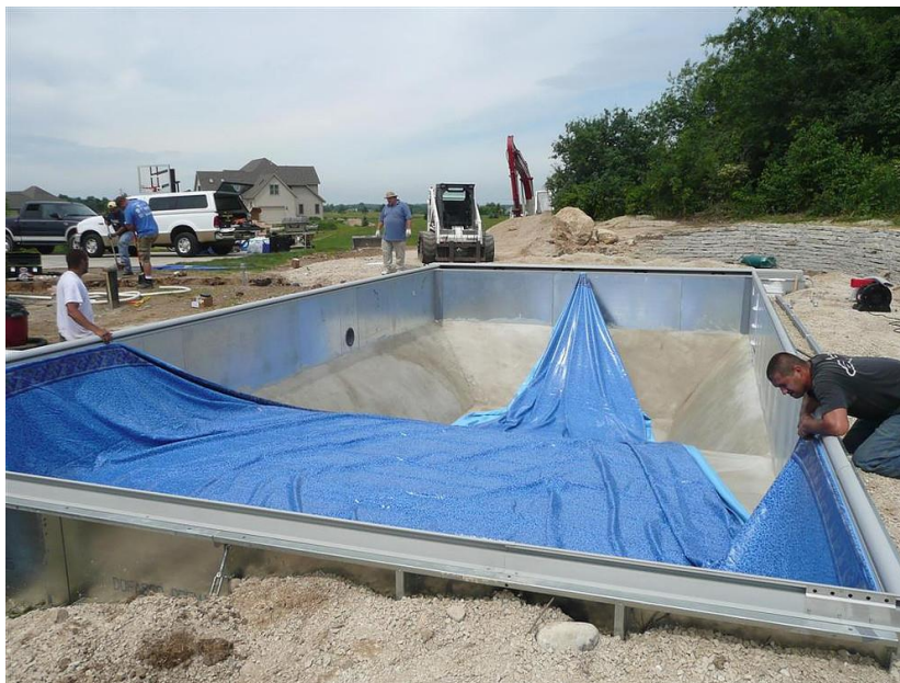
Obr. č. 15 – Předřezaná fólie při instalaci; olsconstruction.com
