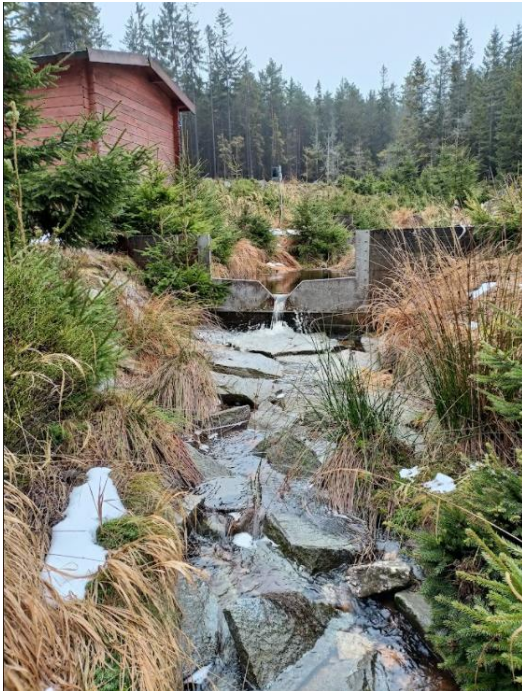
Obrázek 6 a 7 - měrný přeliv a pohled na smýcenou plochu v uzávěrovém profilu Litavka-Krmelec současnost
