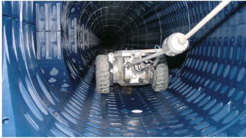
Obrázek 19 - Revizní kanál Q-Bic pro inspekční kontrolu [4]
