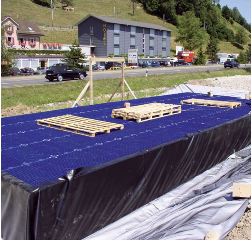
Obrázek 28 - Příklad realizace podzemní nádrže z prvků Wavin [4]
