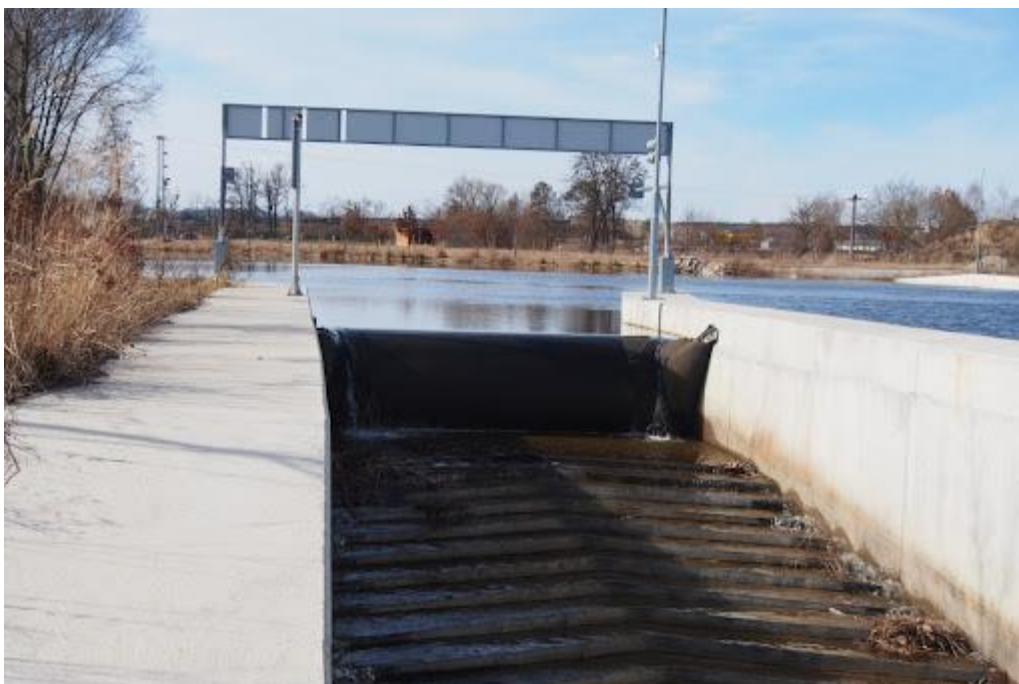
Obrázek 10: SP hrazená vakovým uzávěrem v Plané nad Vltavou [1]
