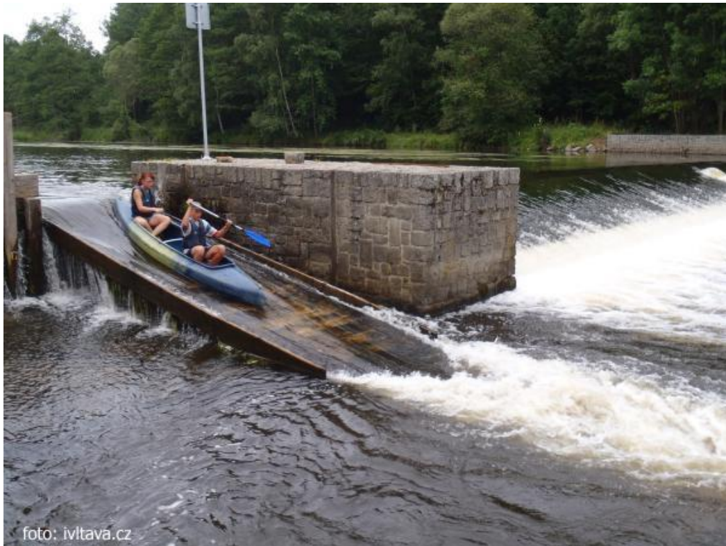
Obrázek 7: Adaptace vorové propusti na jezu Herbertov [1]
