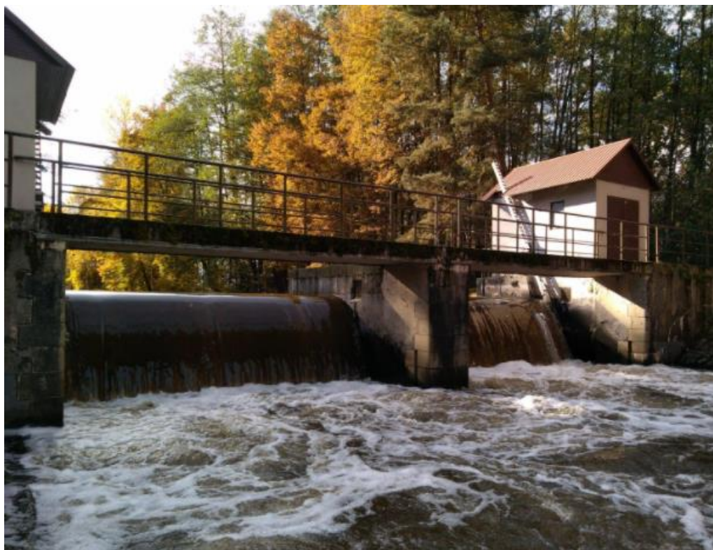
Obrázek 25: Jez Frahelž za zvýšeného průtoku [1]
