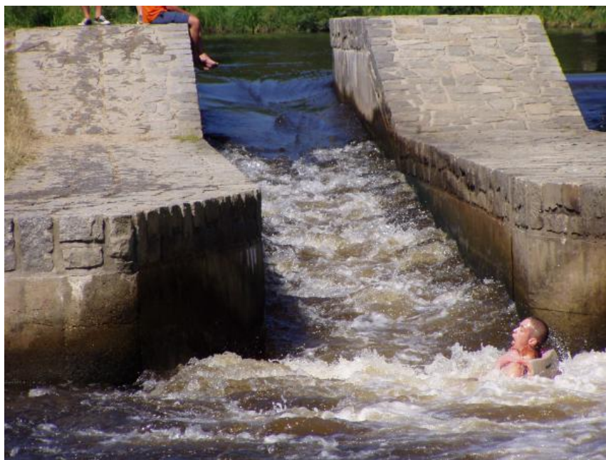
Obrázek 9: Propust jezu Zlatá Koruna [1]
