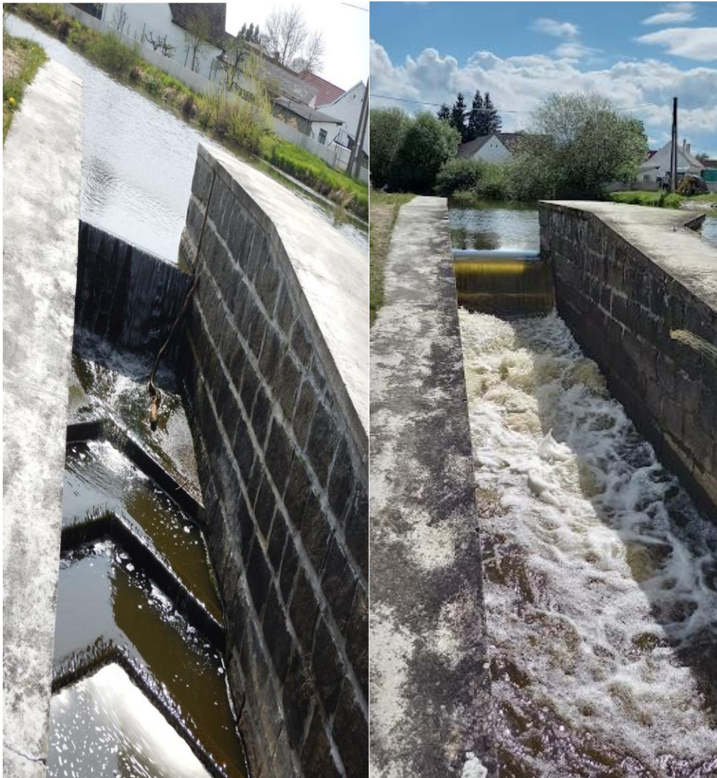
Obrázek 35: Štěrková propust za nízkého a mírně zvýšeného průtoku (zdroj: vlastní archiv a [1])
