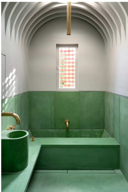
Obrázek 2.8. Vana, umyvadlo a obložení koupelny z probarveného betonu [8]
