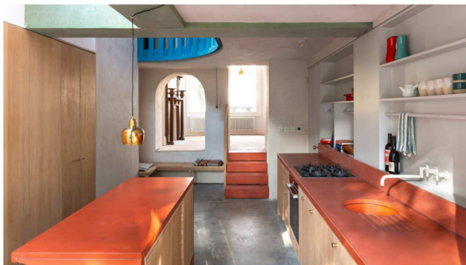
Obrázek 2.7. Použití probarveného betonu v kuchyni [8]
