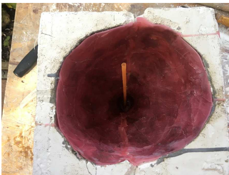
Obrázek 8.4. Forma připravená k betonáží
