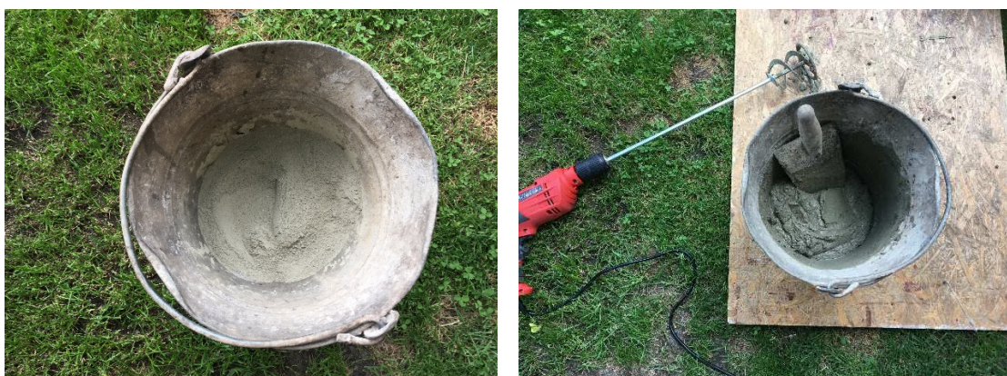
Obrázek 8.5. Míchání betonové směsi
