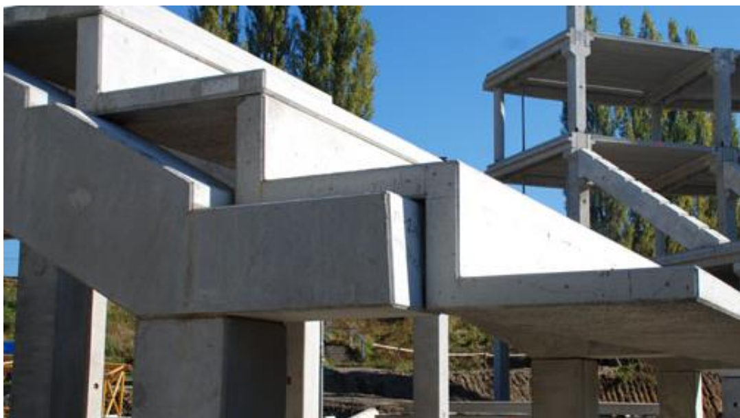
Obr. 2.4 Detail napojení tribunového prvku na šikmý nosník [3]
