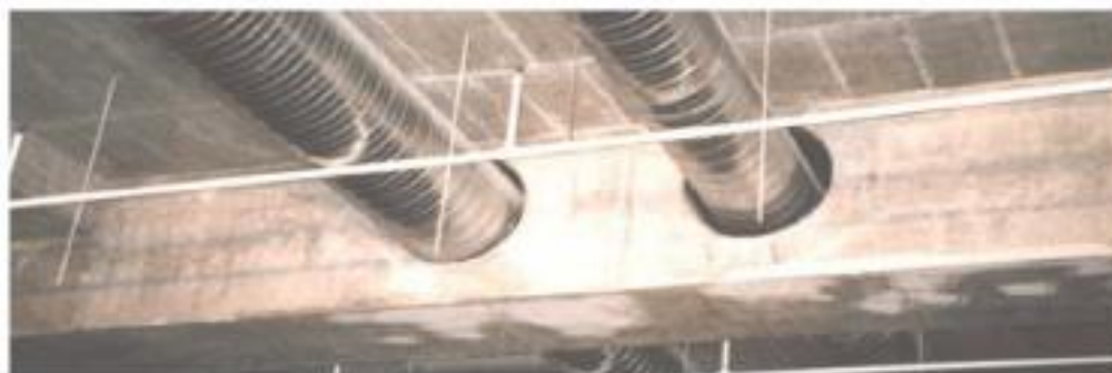
Obr. 2.1 Ukázka vedení inženýrské sítě otvorem v nosníku [4]
