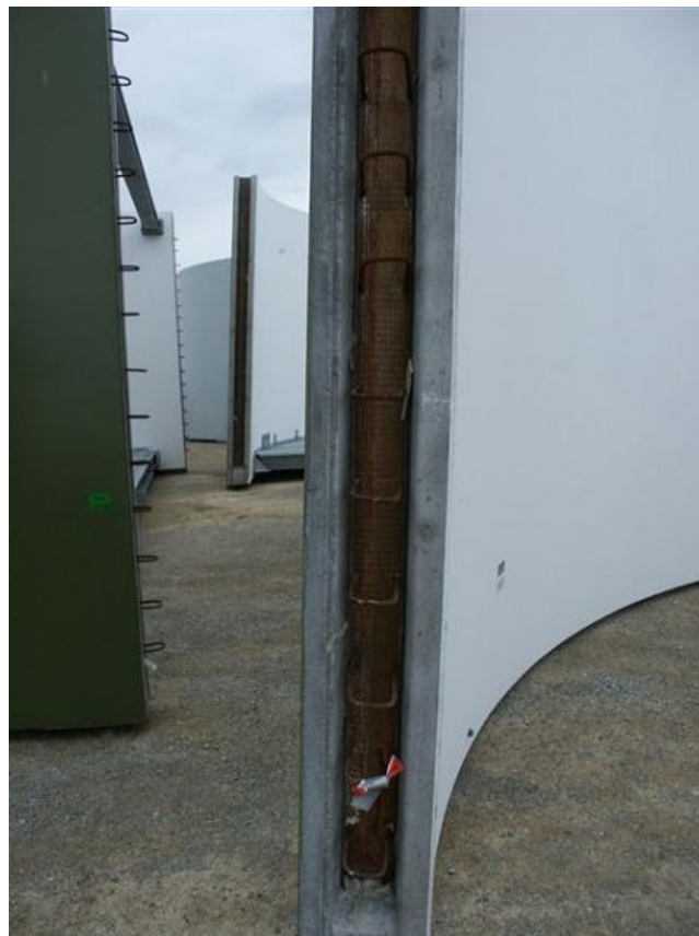
Obrázek 7- Ukázka svislého spoje u půlkruhového segmentu-varianta tzv. petlicového spoje [1]
