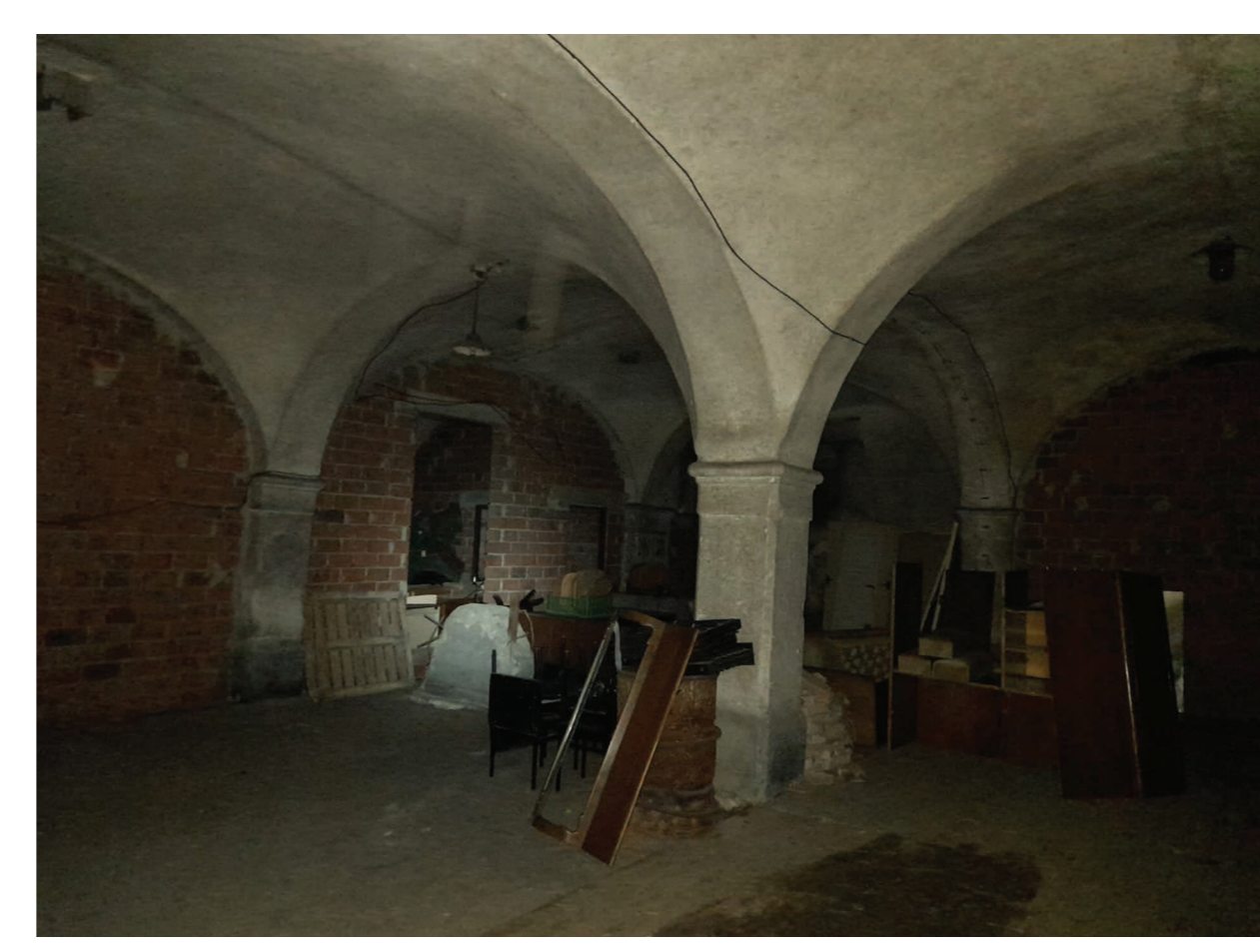
Obr. 2: Rozsáhlé sladovnické humno je zaklenuto plackovými klenbami na kamenných sloupcích
