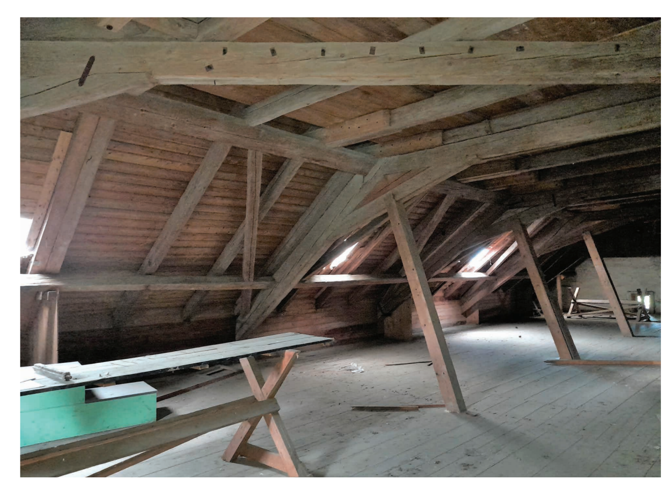
Obr. 3: Hambálkový krov s podélným vázáním s ležatou stolicí v budově sladovny
