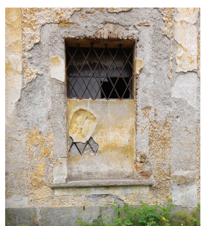
Obr. 6: Barokní okno s kamenným parapetem a mříží
