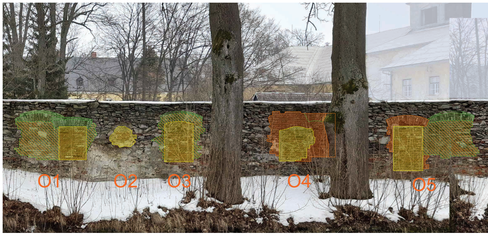
Stavba u podolského potoka postavena nejspíše v barokním období za účelem prostorných stájí – zadržena nízká okna klenutá číhlymi s doprovodným obloukem. V 19. století byla budova nejspíše adaptována z větší části pro bydlení. Nízká okna hospodářského provozu byla zazděna a nahrazena novými většími
