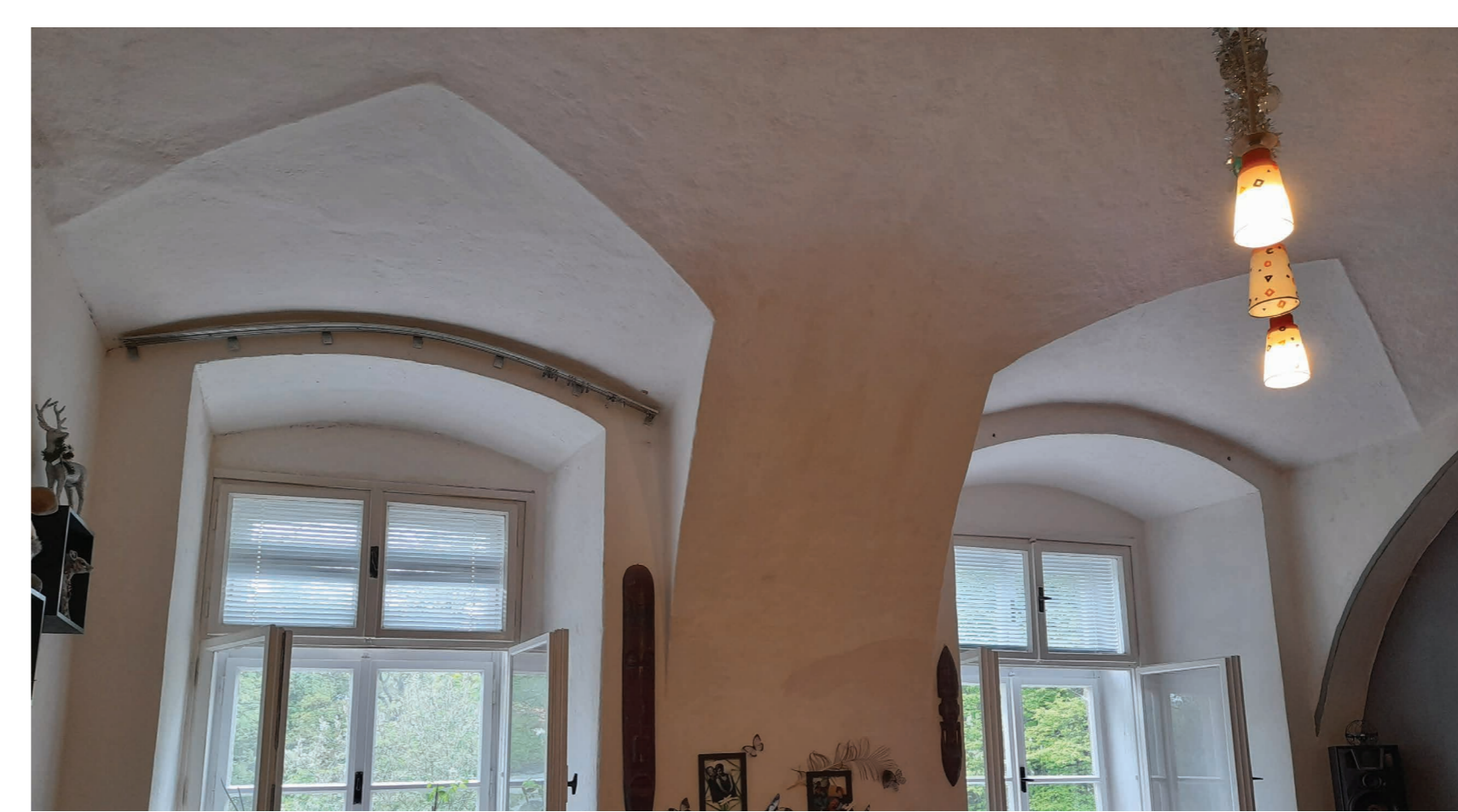
Obr. 5: Se stářím budovy druhově korespondují pětiboké výseče v plackové klenbě pro okna v patře
