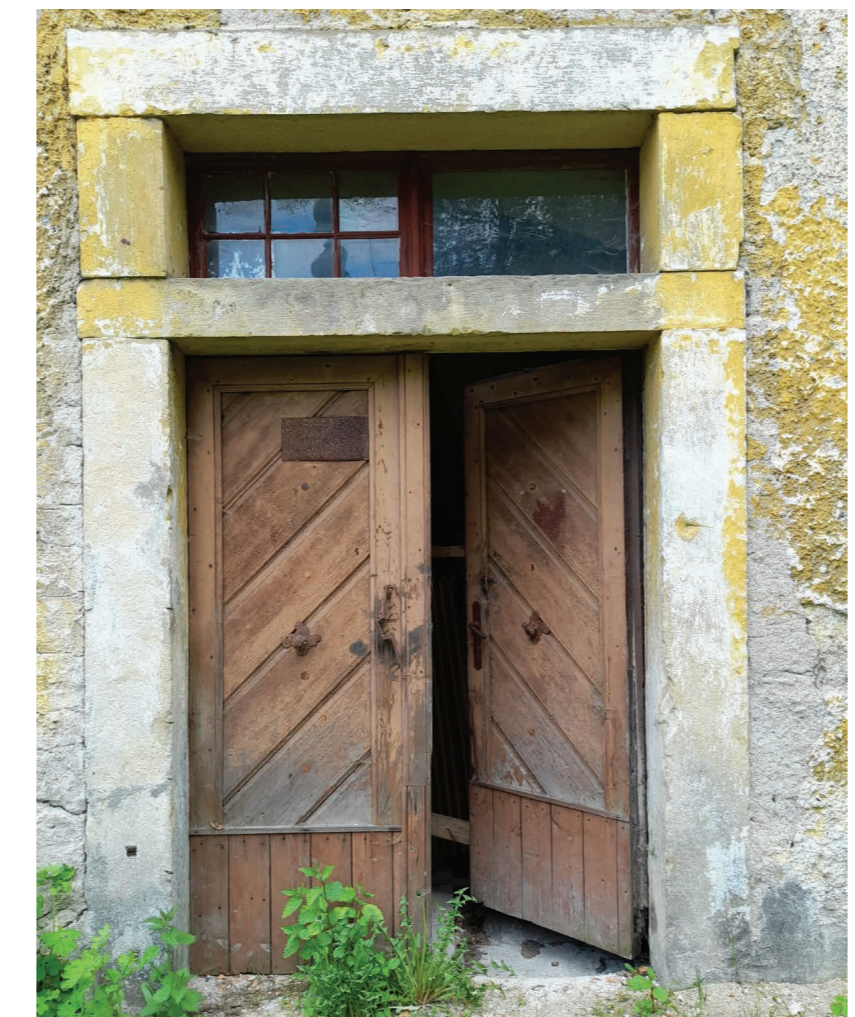
Obr. 4: Kamenný portál sladovny s nadsvětlíkem vyplněný původními barokními sřlakovými dveřmi. Krabicový zámek s malou klíčkou a vnějšími esičkovými závěsy
