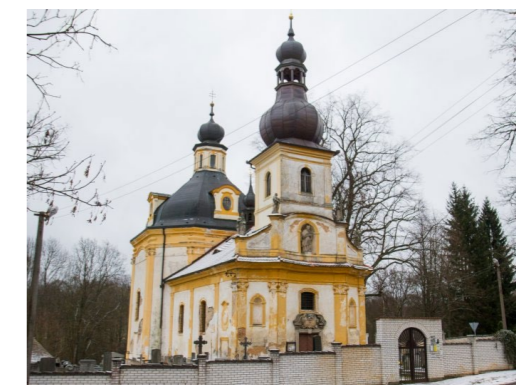
kostel sv. Jana Nepomuckého v Nových Mitrovicích
