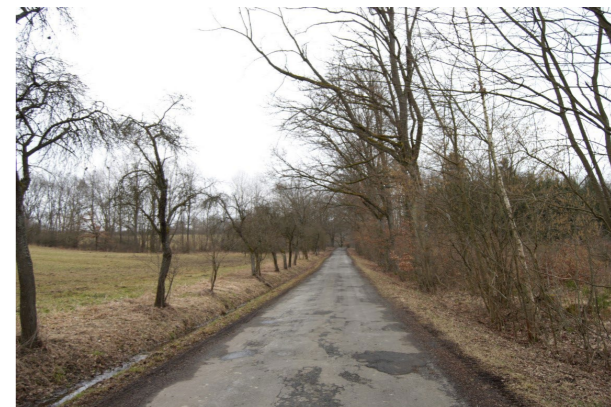
Silniční komunikace mezi Čížkovem a Přešínem
