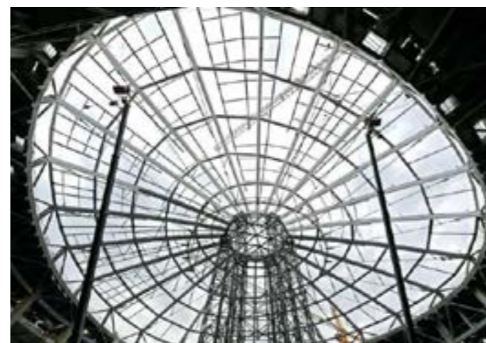
střešní konstrukce stadionu
