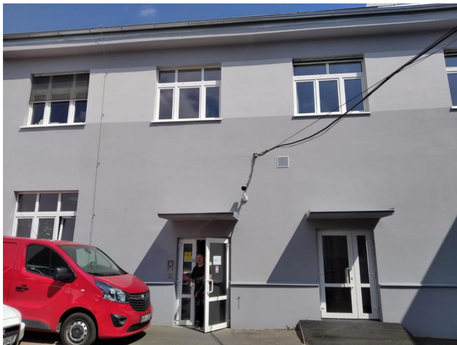
Foto 1 – pohled na fasádu objektu
