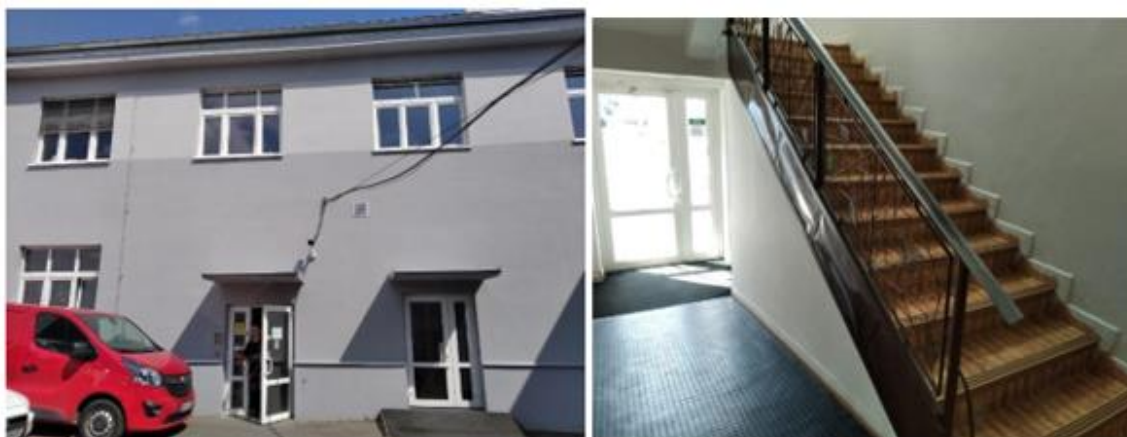
Obrázek 10 – fotografie oceňovaného objektu (pohled na fasádu, vstupní chodba se schodištěm)
