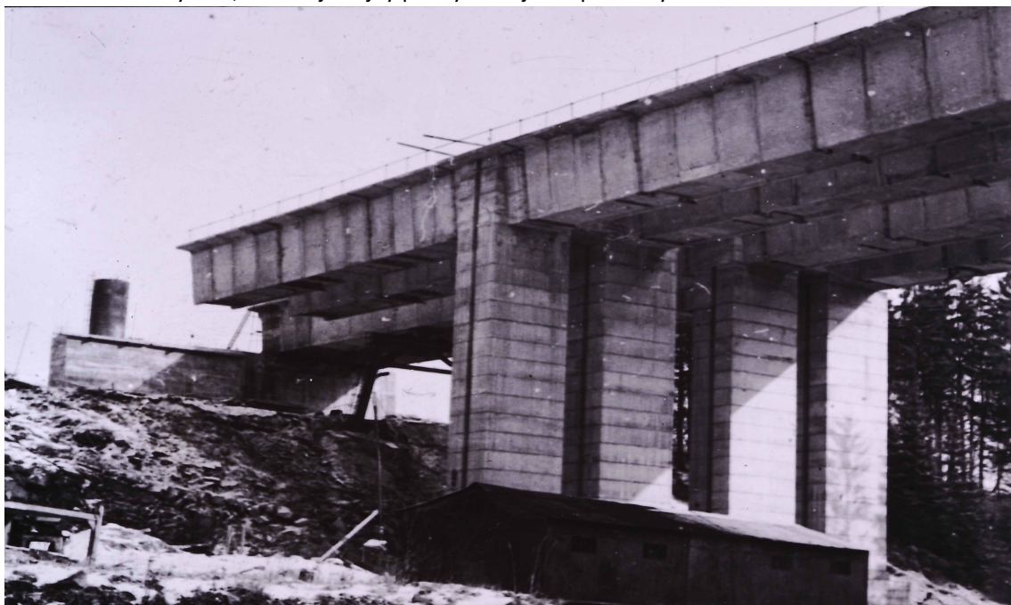
Obrázek 2 výstavba mostu u Koberovic
