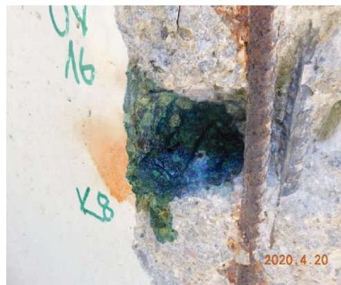
Obrázek 117 zkoušení karbonatace - pH betonu
