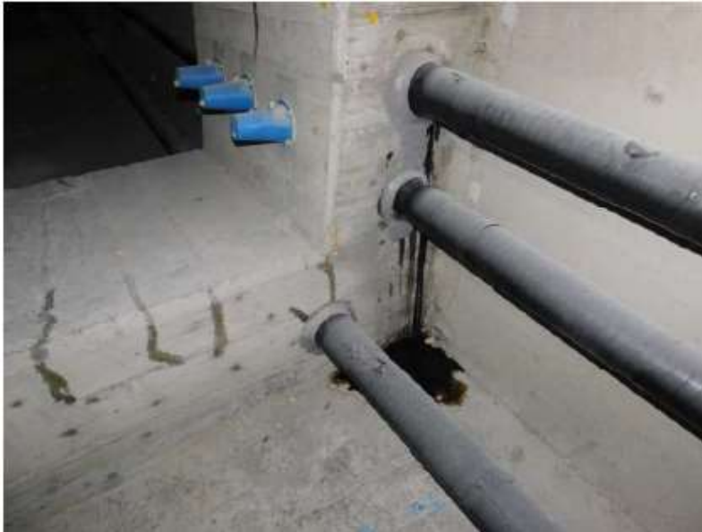
Obrázek 122 únik výplně mezi chráničkou a průchodkou
