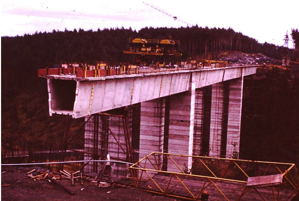
Obrázek 69 provizorní podpory mostu u Sedlice
