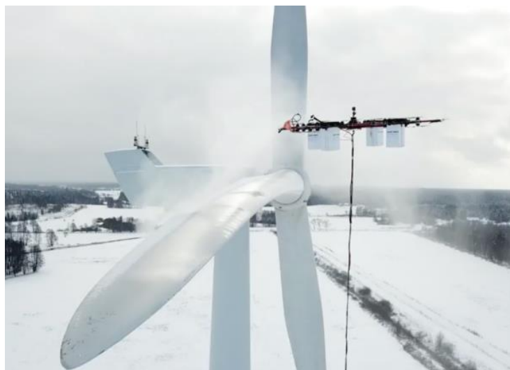
Obrázek 10: Upoutaný dron firmy Aeronos provádí de-icing větrné elektrárny [82]
