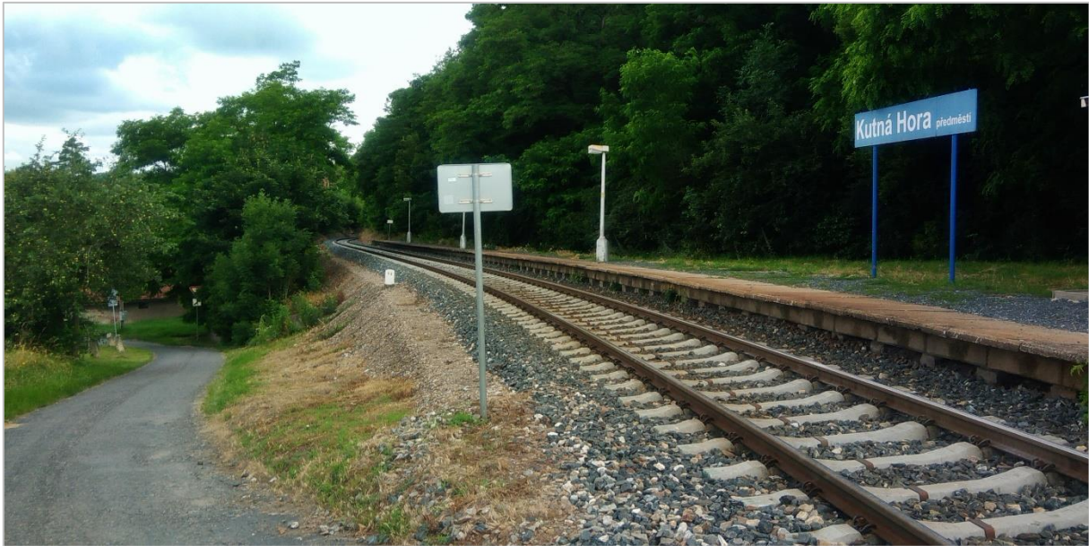
Obrázek 33: Pohled do místa navrhované polohy nástupiště; vlastní fotodokumentace (07.07.2020)
