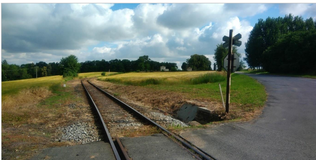
Obrázek 19: Pohled z přejezdu P5975 směrem ke Kutné Hoře; vlastní fotodokumentace (07.07.2020)
