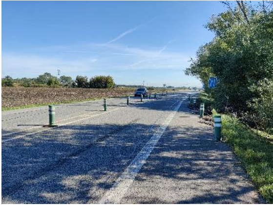
Obrázek 47: Směrové sloupky zelené (Z11h) na příjezdu ke křižovatce ze západního směru
