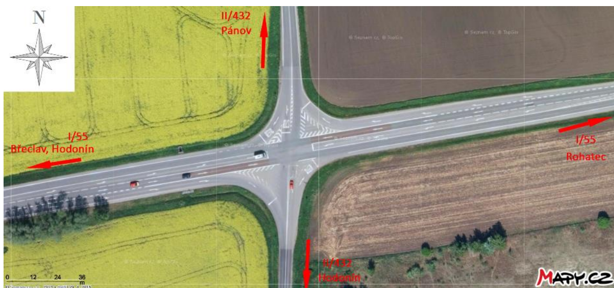
Obrázek 42: Letecký pohled na křižovatku silnic I/55 a II/432 (zdroj: mapy.cz)
