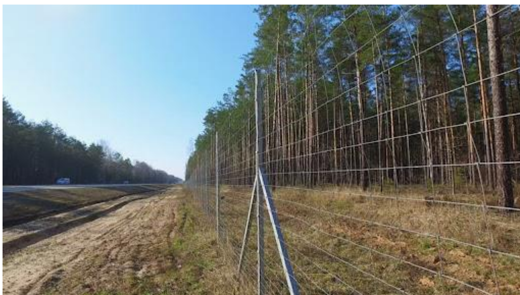
Obrázek 56: Ukázka oplocení silnice [18]
