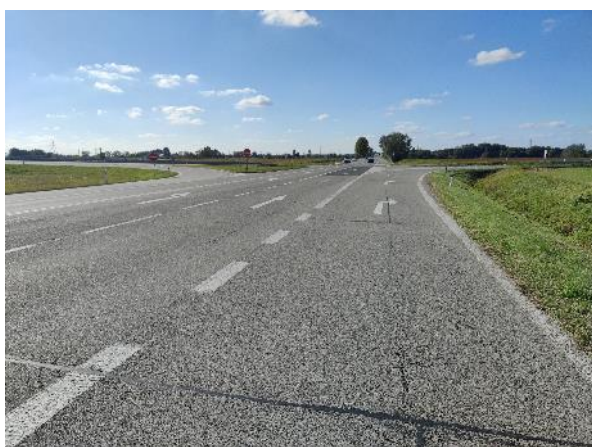
Obrázek 21: Východní paprsek křižovatky (silnice I/55 od města Hodonín) silnice I/55, dálnice D2 a dálnice II/425
