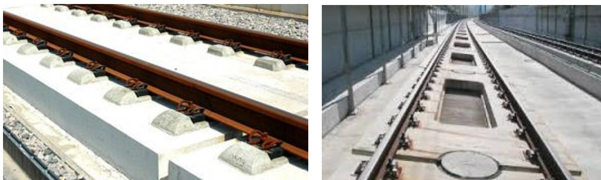
Obr. 2.9: Systémy pevné jízdní dráhy (vlevo: RHEDA 2000; vpravo Shinkansen)
