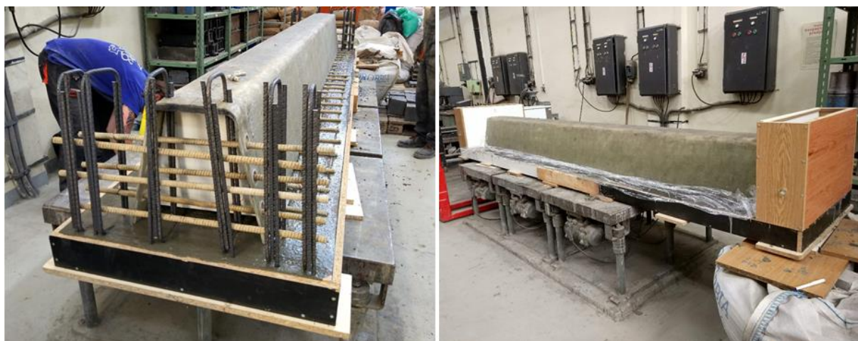
Obr. 62 Vnoření nosníku do betonové směsi, betonáž příčníků
