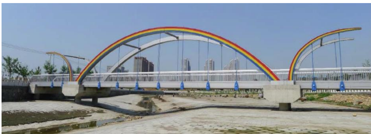
Obr. 32 Lávka o délce 45 m (9+ 27 +9 m) v provincii Hebei v Číně
