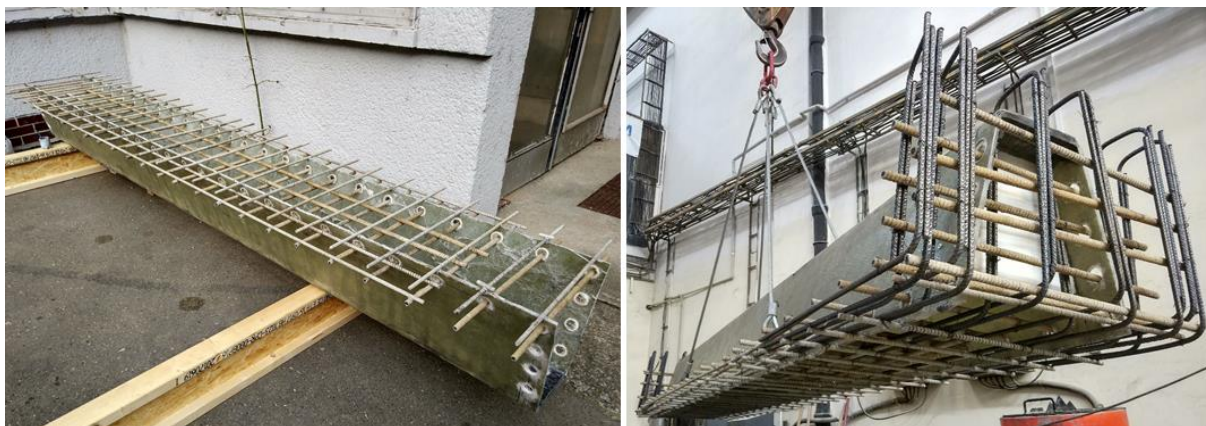
Obr. 60 Nosník po vyvázání FRP výztuže, nosník po doplnění výztuže příčníků
