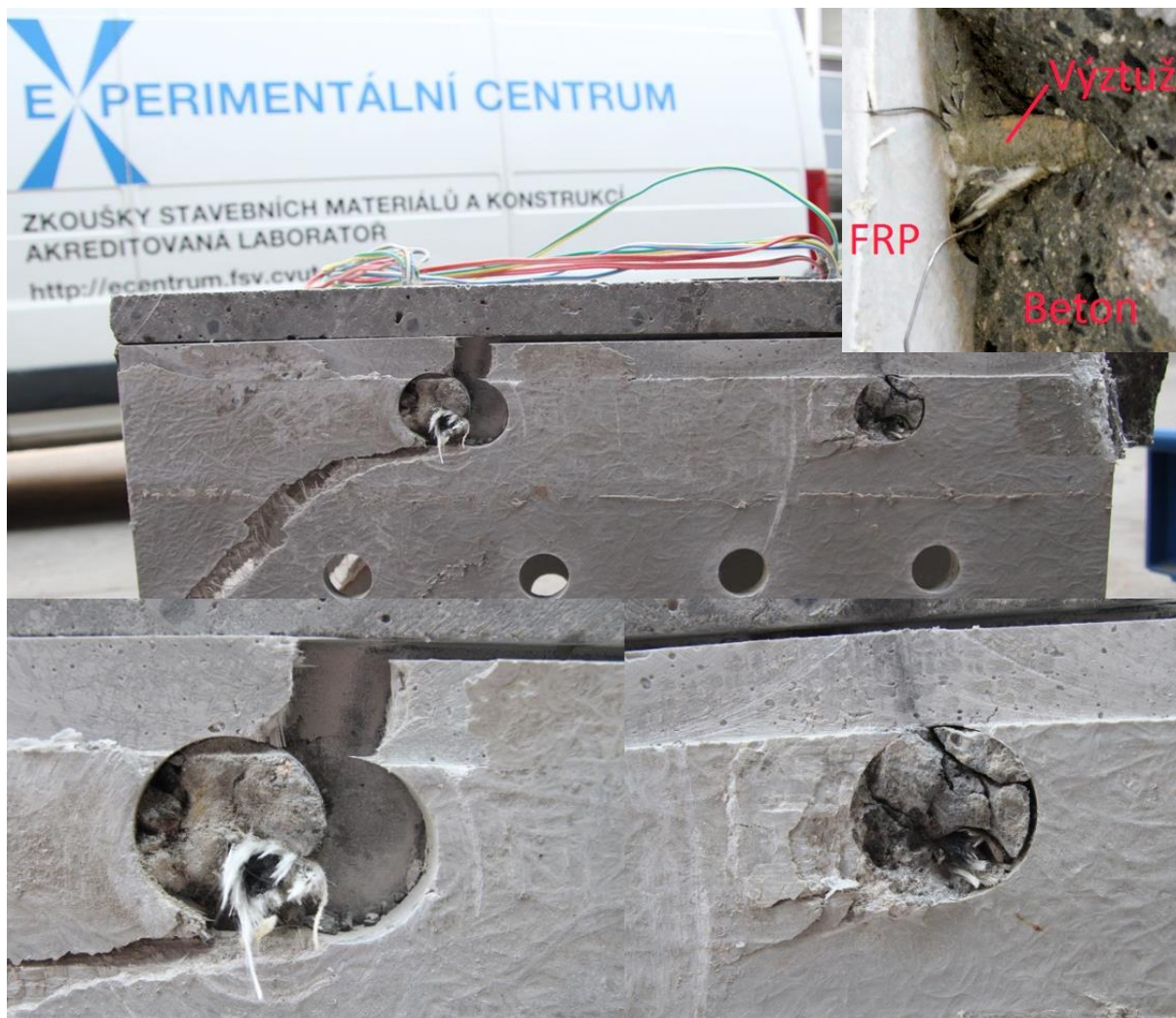
Obr. 47 Detail porušení spřahovací lišty – vzorek č. 3
