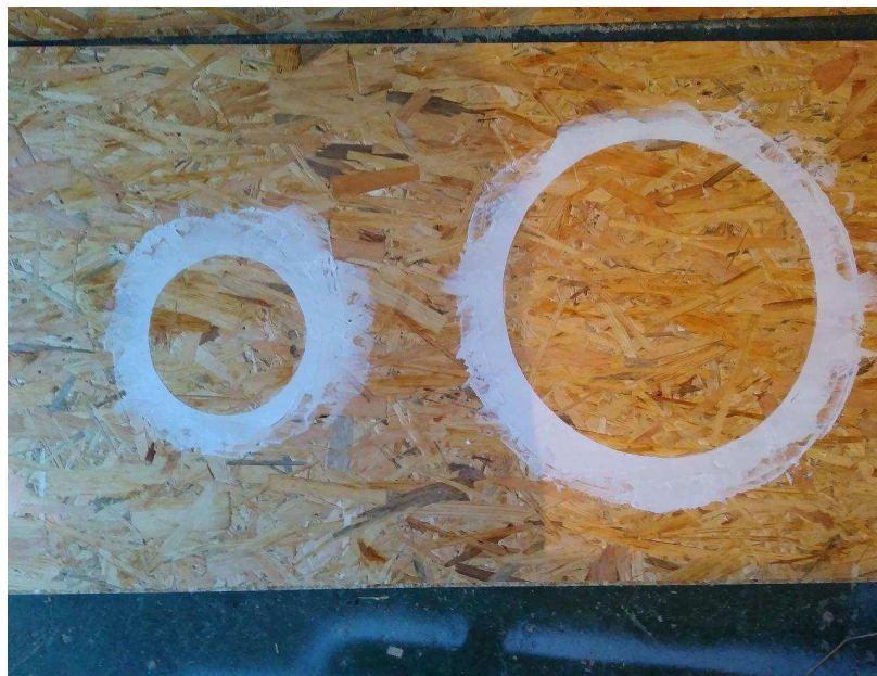
obr. 33: Příprava těsnící vrstvy z akrylátové emulze
