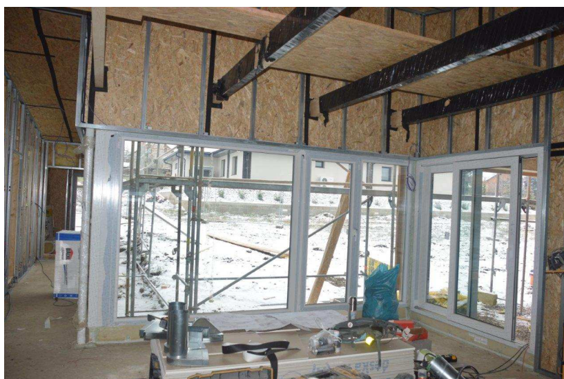
obr. 60: Pohled do interiéru stavby
