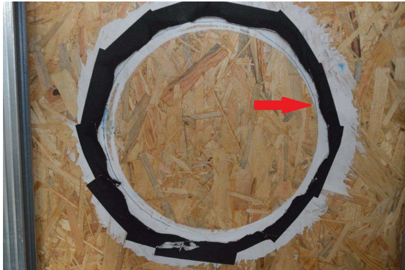
obr. 65: Testované místo po odsazení měřicí komory, červenou šipkou označeno místo, kde hrdlo komory bylo mimo prstenec z akrylátového tmelu, vzduchotěsná páska je černá
