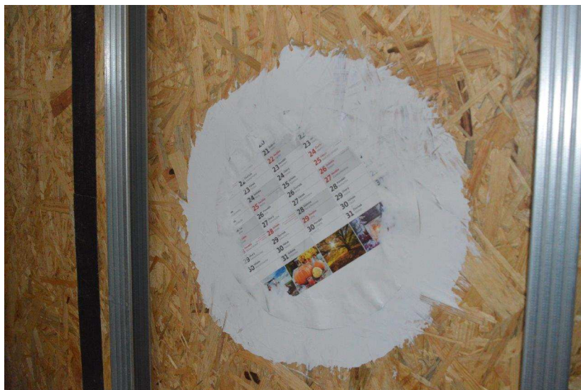
obr. 61: Příprava těsnícího prstence z akrylátového tmelu
