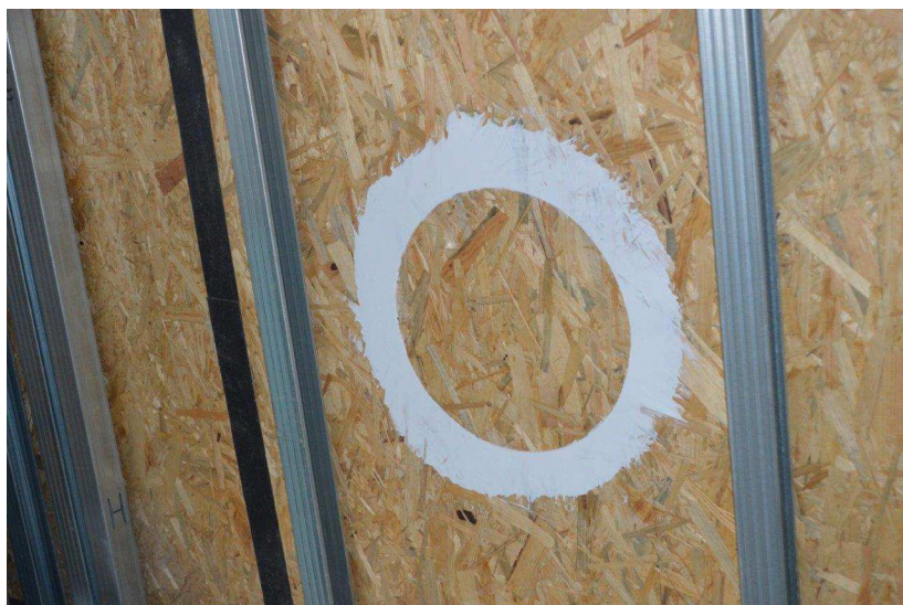
obr. 62: Hotový prstenec z akrylátového tmelu
