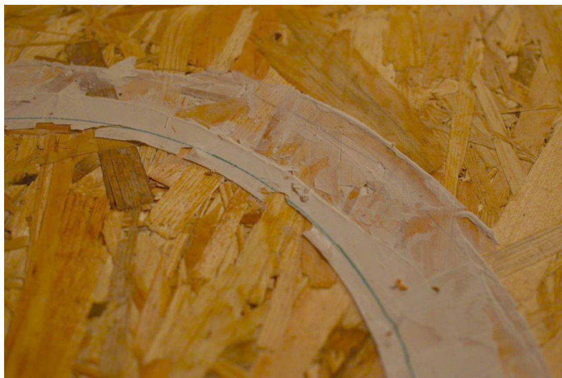
obr. 40: Potrhání těsnicího prstence z akrylátového tmelu po odsazení zkušební komory
