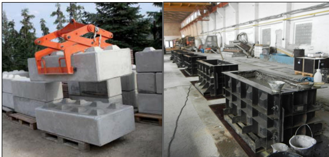
Obr. 27a a 27b: Betonové bloky vyráběné v rámci provozních zkoušek popílkového betonu na betonárně v Hulíně. Obrázek 27a je ilustrativní, nebyl pořízen při samotné betonáži.
