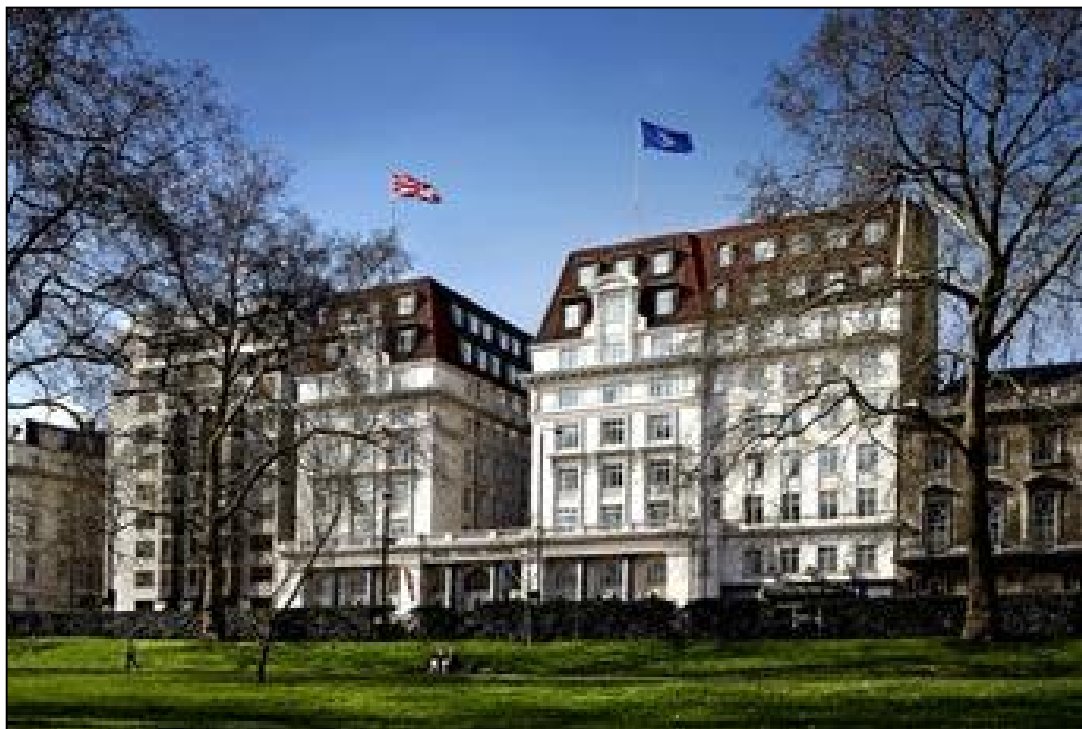
Obr. 7 Park Lane Hotel - užití HVFAC na vyztužené sloupky, Canada, 1988 [18].
