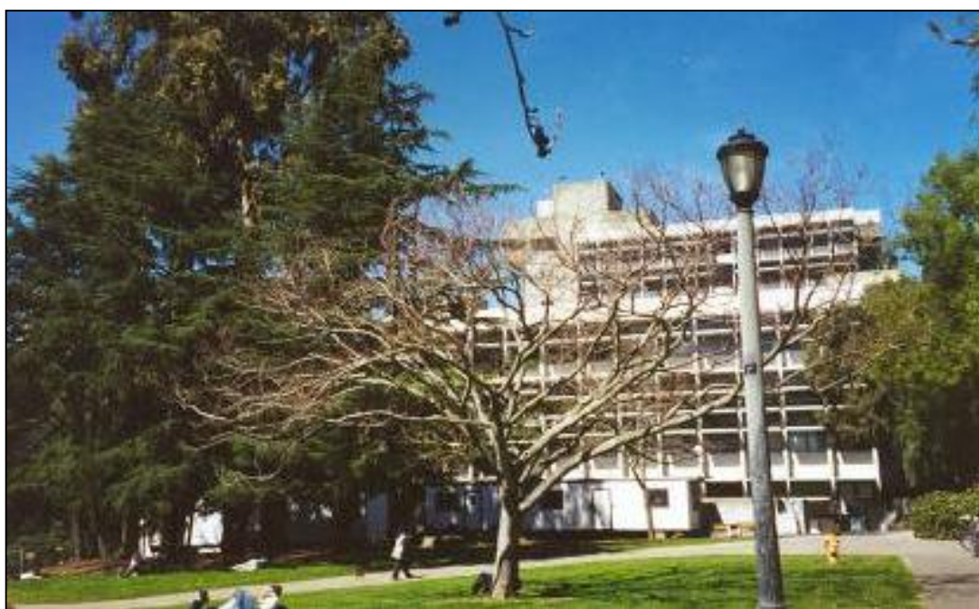
Obr. 8 Wurster Hall, University of California – HVFAC byl použit na pilíře a základy, USA, 2001 [19].
