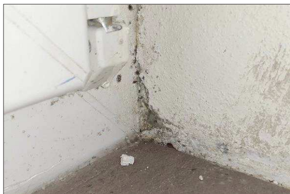
Obr. 37: Projev plísně na vnitřním ostění okna
