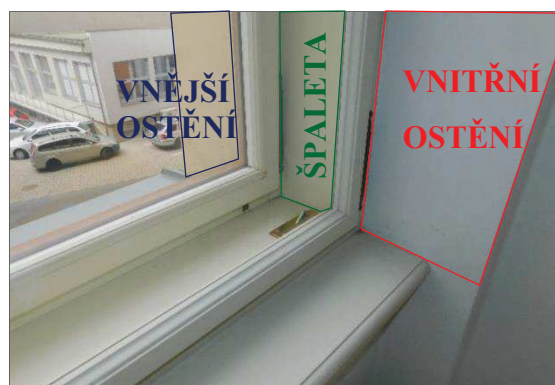
Obr. 23: Ostění u původní konstrukce dvojitého okna, části ostění: vnitřní, mezi, vnější
