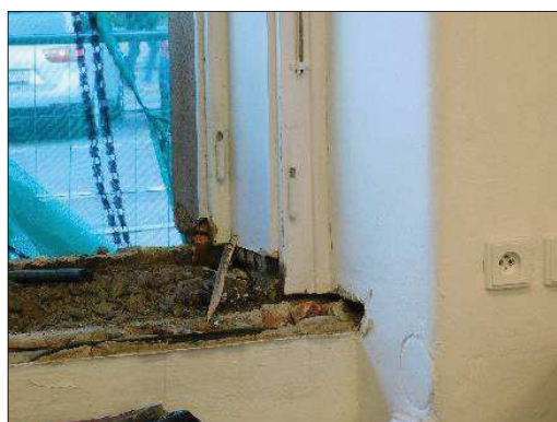
Obr. 27: Vybourání parapetní části okna
