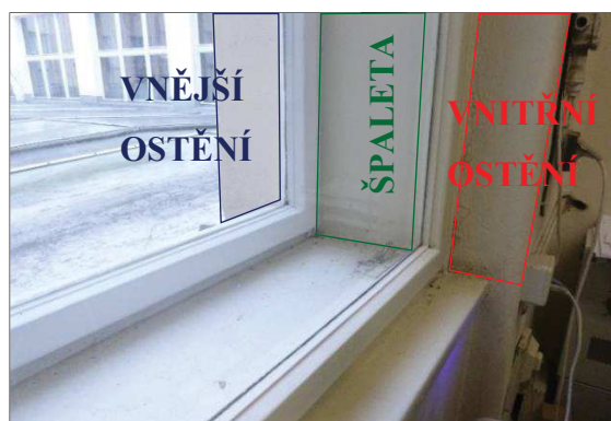
Obr. 23: Ostění u původní konstrukce dvojitého okna, části ostění: vnitřní, mezi, vnější
