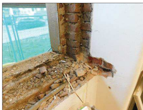
Obr. 28: Stavební otvor po vybourání okenní konstrukce (stavební konstrukce je z 30. let 20. století)
