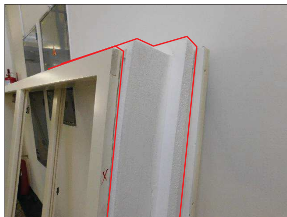
Obr. 19: Zateplení prostoru pod dřevěnou špaletou, konstrukce dvojitého okna před instalací do objektu
