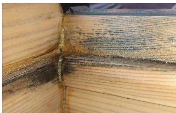
Obr. 16: Projev plísní na dřevěné konstrukci okna
