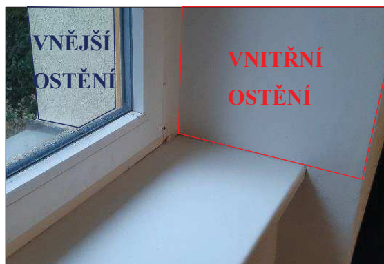
Obr. 25: Ostění u novodobé konstrukce dvojitého okna, části ostění: vnitřní, špaleta a vnější
