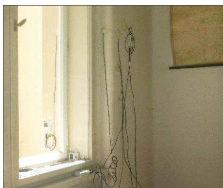
Obr. 31: Osazená konstrukce měřicími zařízeními
