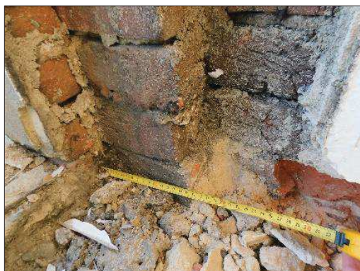
Obr. 29: Detailní fotografie tvaru a stavu ostění
