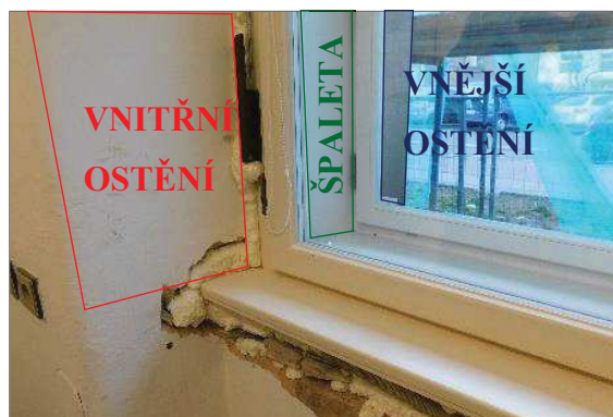
Obr. 25: Ostění u novodobé konstrukce dvojitého okna, části ostění: vnitřní, špaleta a vnější
