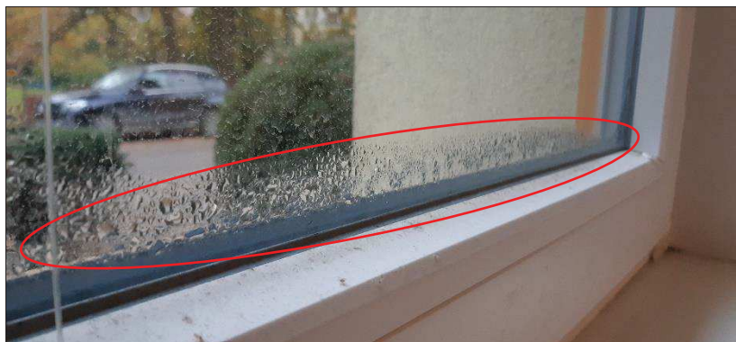
Obr. 14: Projev kondenzace na zasklívací spáře okenní konstrukce
