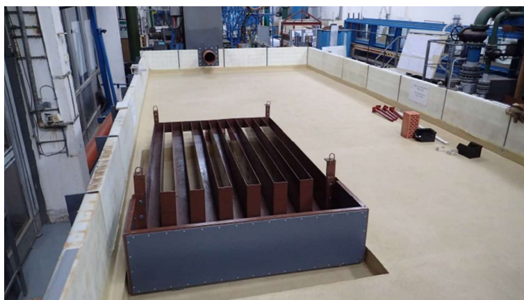
Obr. 4.5 Baterie přepadových žlábků
