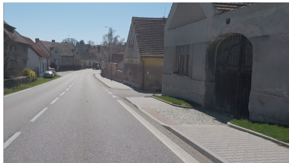
Obrázek 44: Adekvátně provedená pěší infrastruktura, silnice I/22 – Střelské Hoštice. [26]
