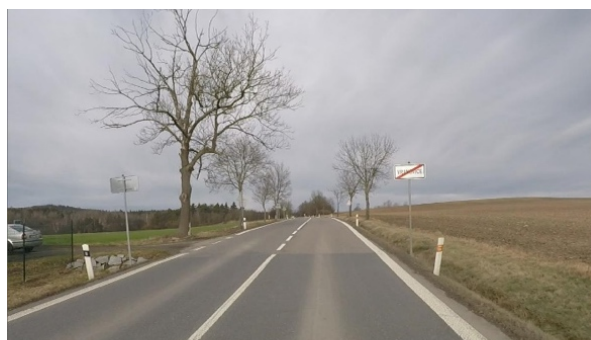
Obrázek 28: Prostorové vedení PK, které výrazně neovlivňuje rychlost (vrcholový oblouk), silnice I/18 – Vranovice. [26]
