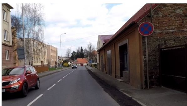
Obrázek 45: Neadekvátně provedený (úzký, nerovný a neadekvátně vyvýšený) chodník, Silnice I/27 – Domažlice. [26]
