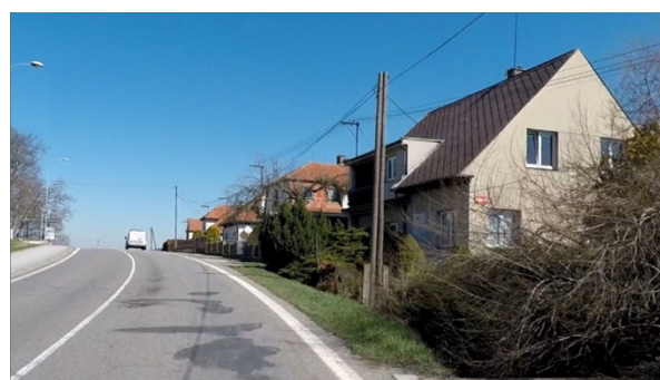
Obrázek 46: Absence pěší infrastruktury, silnice I/4 Volyně. [26]
