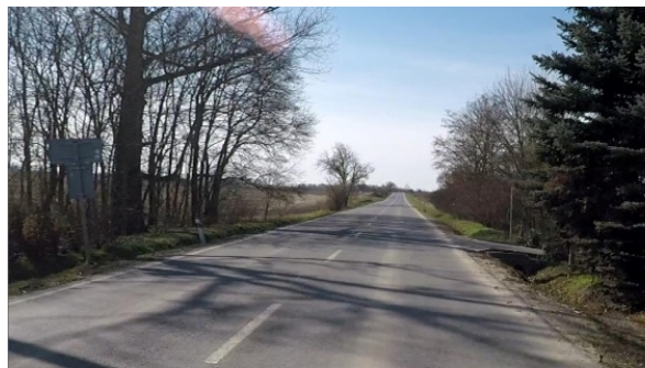
Obrázek 30: Ukázka urychlujícího vedení PK před obcí (dlouhý přímý úsek, klesání), silnice I/16H – Uhy. [26]
