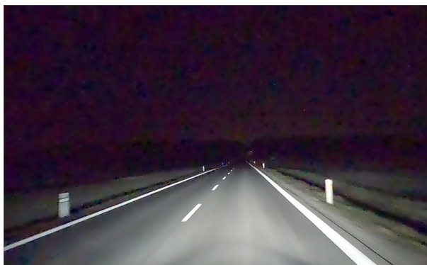
Obrázek 9 – Adekvátní odrazivost VDZ V 2a, V 4. [5]
