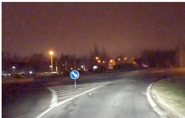
Obrázek 13 – Absence DZ Z 3 za snížené viditelnosti. [5]
