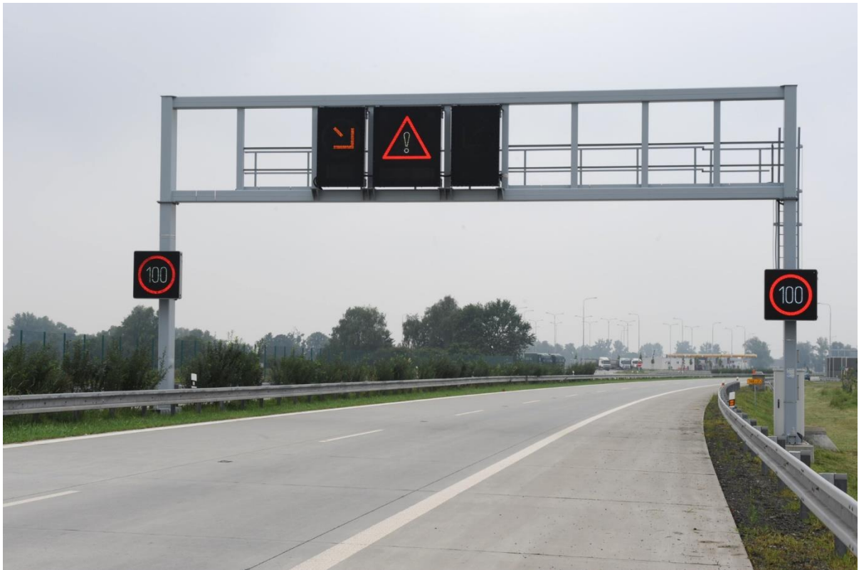
Obrázek 2: Portál liniového řízení dopravy [17]
