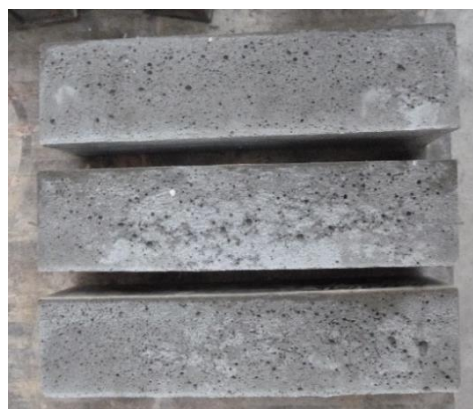
Obr. 67 Trámce po odbednění (66)
