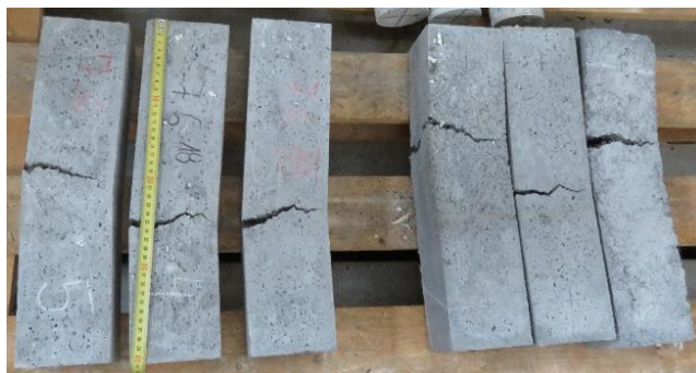
Obr. 120 Trámce po zkoušce tahem za ohybu (66)
