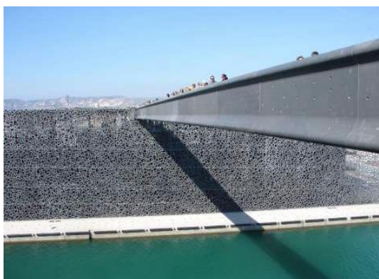
Obr. 28 Pohled na lávku z UHPC (21)
