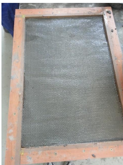
Obr. 55 Bednění desky s čerstvým betonem a vloženou čedičovou textilií (66)
