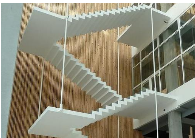
Obr. 31 Schodiště ve škole Sydhavnsskolen (45)
