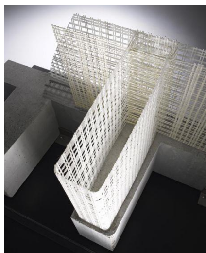
Obr. 40 Detail vyztužení mostu pro pěší v Lautlingenu (54)
