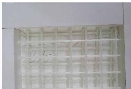
Obr. 93 Detail distančního prvku (66)
