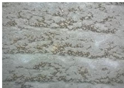
Obr. 88 Detail povrchu desky z vertikálního bednění s patrným rozvrstvením (59)
