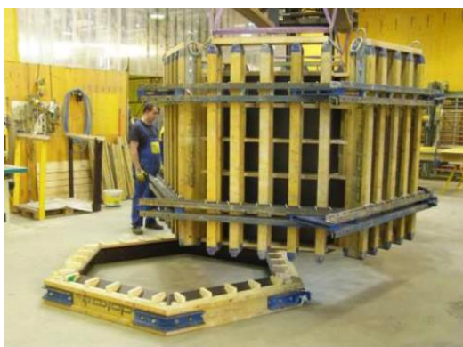
Obr. 24 Dřevěná forma bednění (21)
