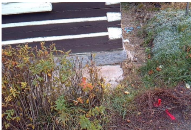
Obrázek 19: Ukázka dočasně stabilizovaného bodu při ZPH 24
