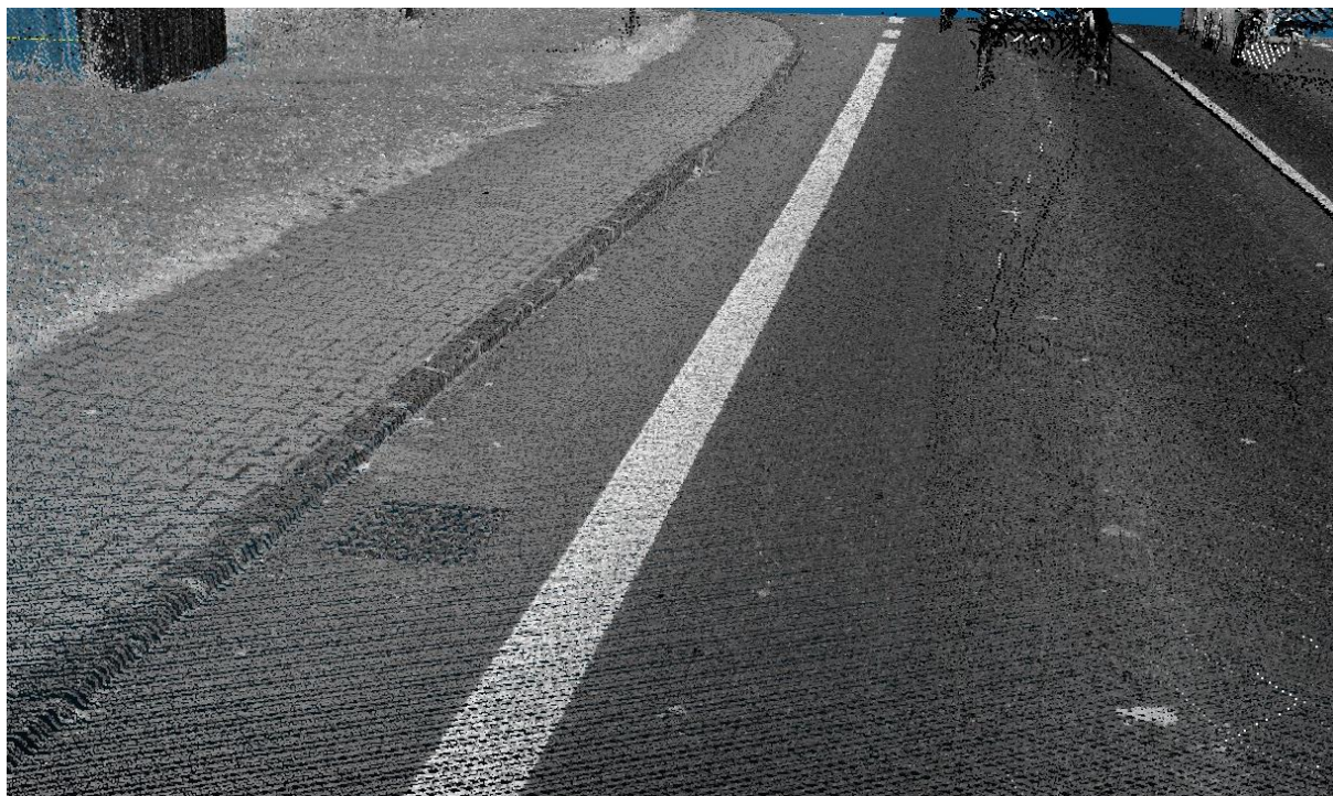
Obrázek 119: Ukázka zaměření obrubníku mezi silnicí a chodníkem
