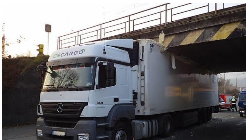
Obrázek číslo 2: Zablokovaný nákladní automobil pod železničním mostem
