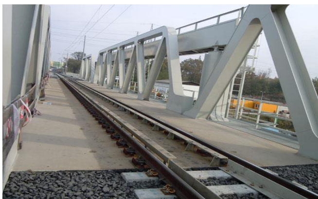
Obrázek číslo 12: Konstrukce s kolejovým ložem
