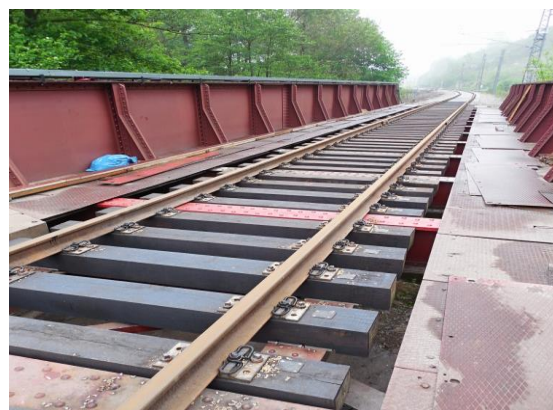
Obrázek číslo 13: Konstrukce s mostnicemi
