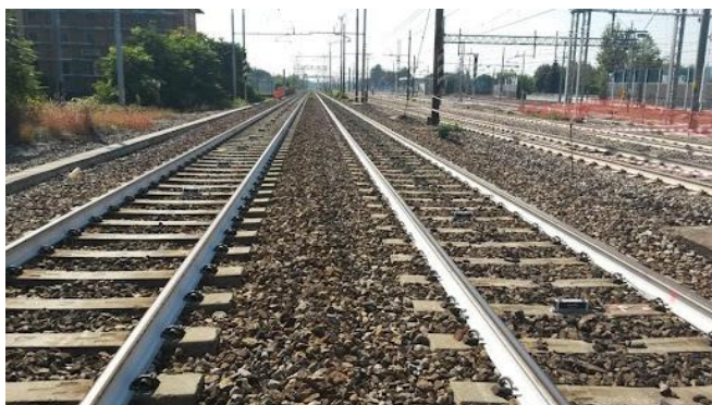
Obrázek číslo 10: Přímé upevnění koleje
