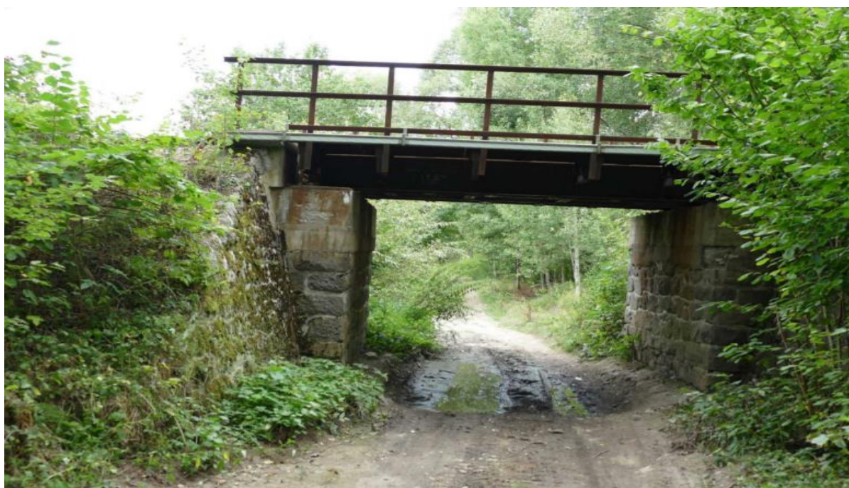
Obrázek číslo 24: Současný stav železničního mostu
