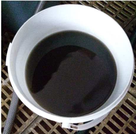
Obrázek 22 – Zakalená voda po prvním proplachu primárního okruhu výměníku
