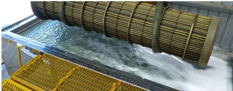
Obrázek 10 – Čištění tepelného výměníku ultrazvukem v lázni [34]
